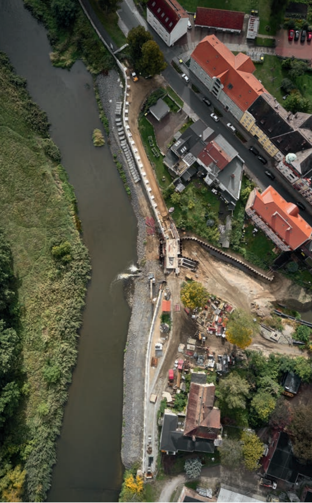
↑ Von rechts kommt die Egelneißer, an deren Mündung eine Fischaufstiegsanlage und ein Auslaufbauwerk entstanden
