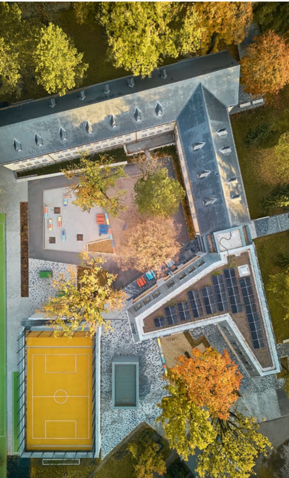
↑ Altbau, Neubau, Sporthalle mit Dachspielfeld, mittig der Schulhof
