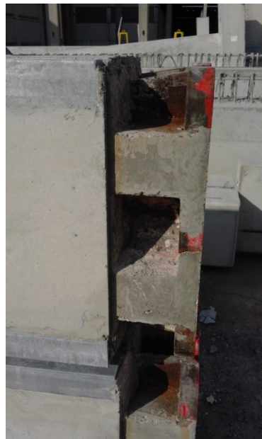
Abb.FA.38: Foto eines eingebauten Stützenschuhs mit 8 Verschraubungen
