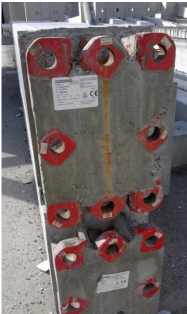
Abb.FA.38: Foto eines eingebauten Stützenschuhs mit 8 Verschraubungen
