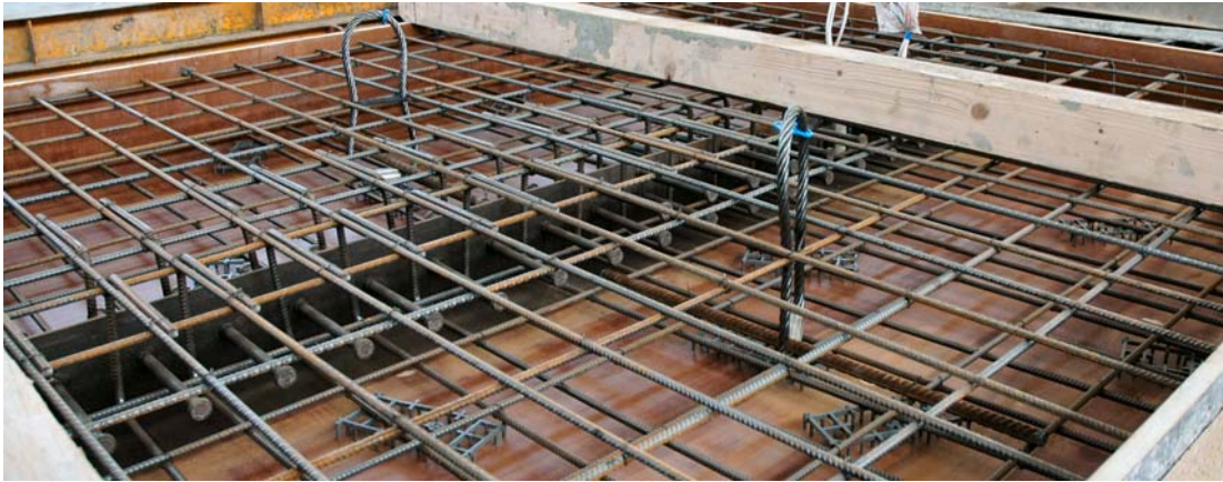
Abbildung 3.4: Bewehrung des Versuchsträgers SF-Q5
