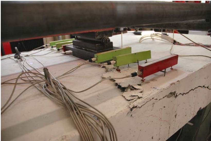
Abbildung 4.4: Versagensbild des Versuchsträgers SF-Q1
