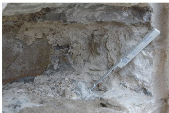
Bild 9 Öffnungsstelle Ost 3: Rechte Flanke der Öffnungsstelle nach dem Herausnehmen des Steins der Außenschale. Größere Hohlstelle in der Stoßfuge (siehe eingesteckter Meterstab)
