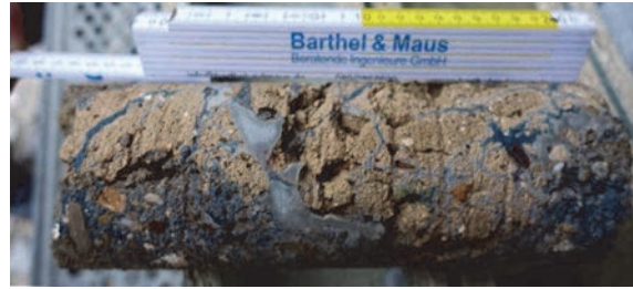
Bild 10 Bohrkern aus dem Versuchsfeld F4 mit historischem Mörtel und Feinstzementsuspension
