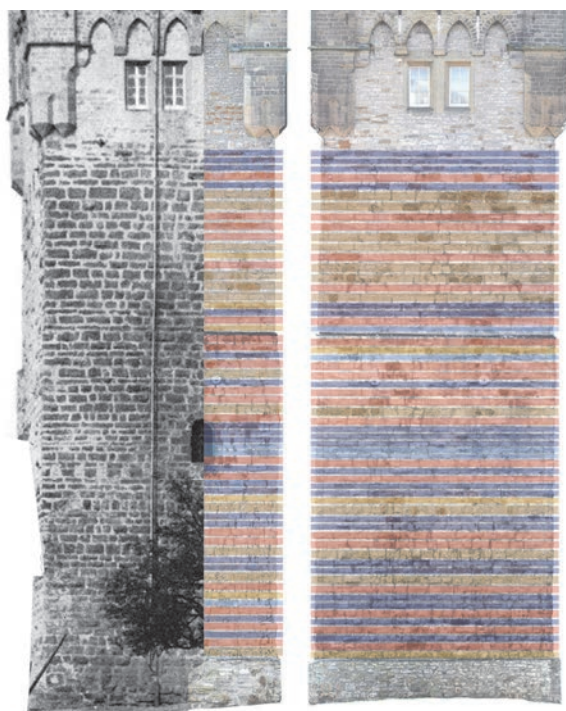
Bild 15 Auswertung der Steinlagen am Turmunterbau. Ostseite (links; in Überlagerung mit einer historischen Fotografie mit noch deutlich erkennbarem Fugenschnitt) und Nordseite (rechts)
