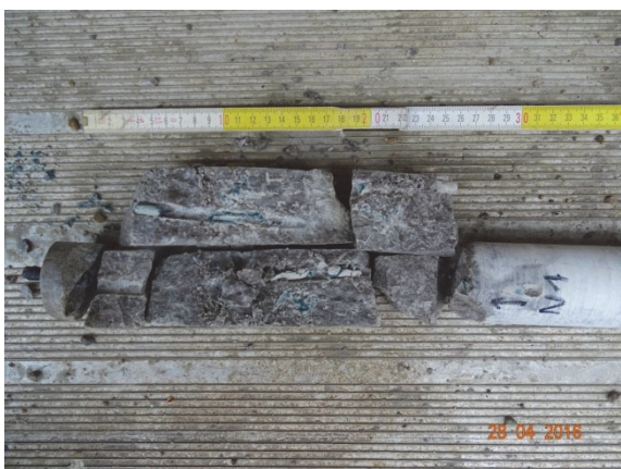
Bild 4 Bohrung N1; in der Mitte des gebrochenen Bohrkernabschnittes ist der mit Mikrozement gefüllte Bohrkern zu erkennen
