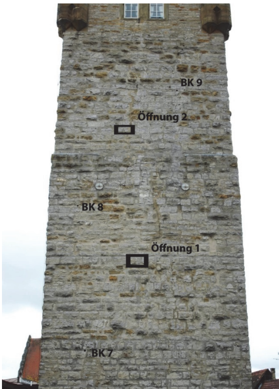
Bild 1 Lage der Bohrkernentnahmestellen 7 bis 9 und der Öffnungsstellen 1 und 2 an der Westseite
