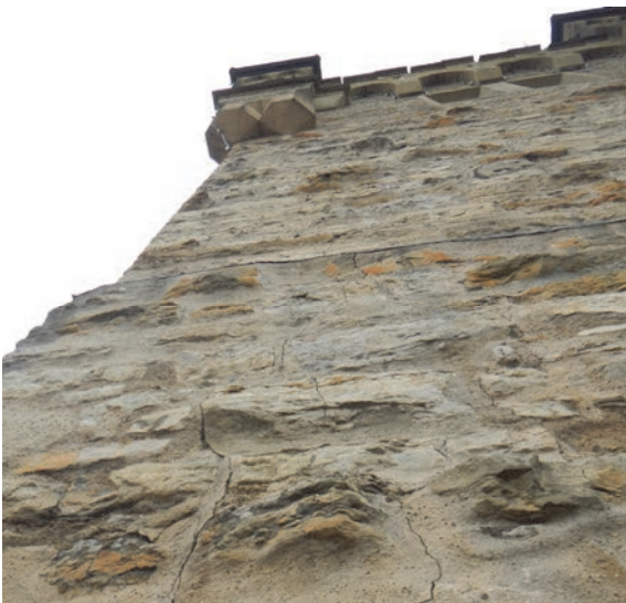
Bild 14 Staufisches Blausteinmauerwerk am Blauen Turm mit teils vorspringenden Bossen
