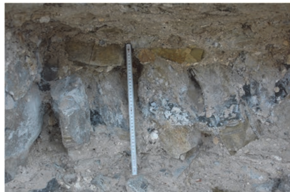
Bild 2 Öffnungsstelle West 1: Diagonal eingebaute, kleinformatige Mauersteine im Hinterfüllmauerwerk bei einer Öffnungstiefe von rd. 60 cm. Zwischen den Steinen historischer Kalkmörtel und Injektionsmörtel (grau)
