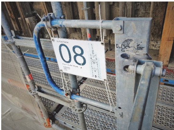
Bild 9 Treffpunkt Gerüstlage 08: Einfache Maßnahmen helfen bei der Orientierung am Bau.
