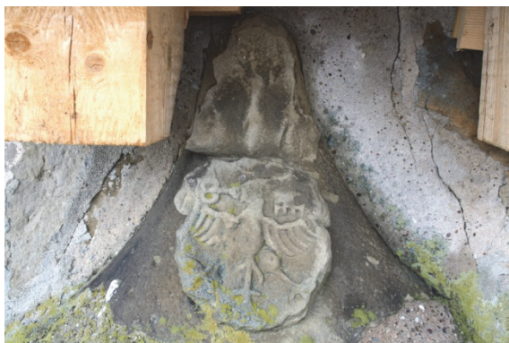
Bild 2 Erker Südfassade aus Sandstein – Wappenrelief an Bedachung
