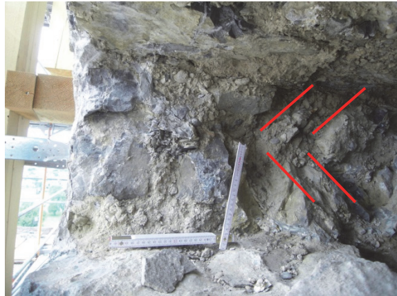
Bild 7 Schrägliegende »opus-spicatum«-Steine im Kernmauerwerk
