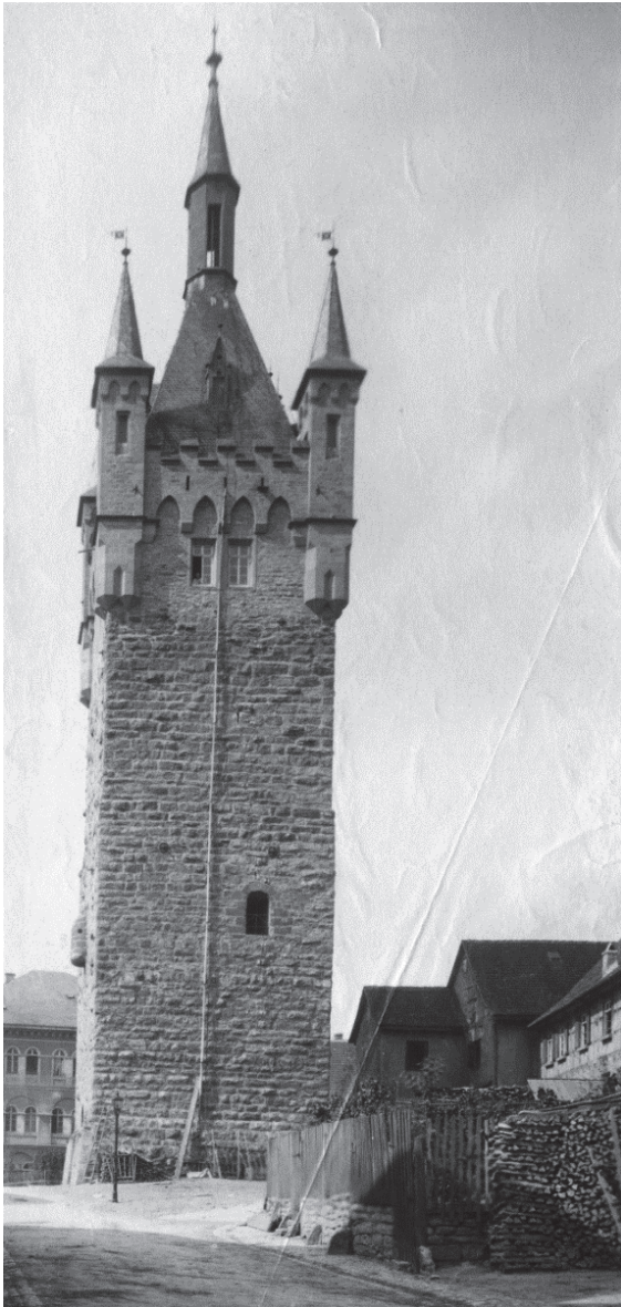
Bild 7 Ostansicht des Blauen Turms mit den vor 1870 über dem ehemaligen Turmzugang eingebauten Zugankern [Altinventar Hessen 1898]
