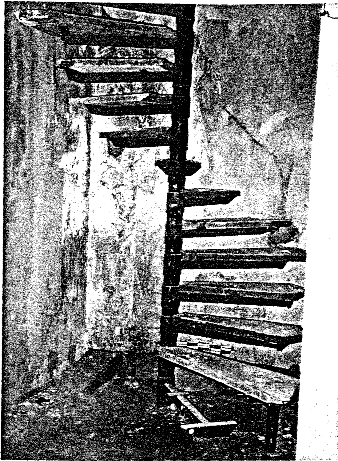
Abb. 27: Antritt der Stahlspindel- treppe
