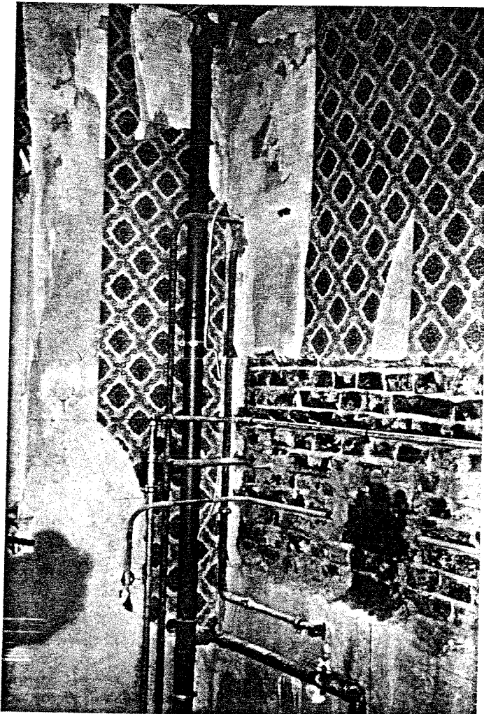
Abb. 30: Neu verlegte Versorgungsanschlüsse für die Küche; Putzentfernung zum Anbringen eines Fliesenspiegels
