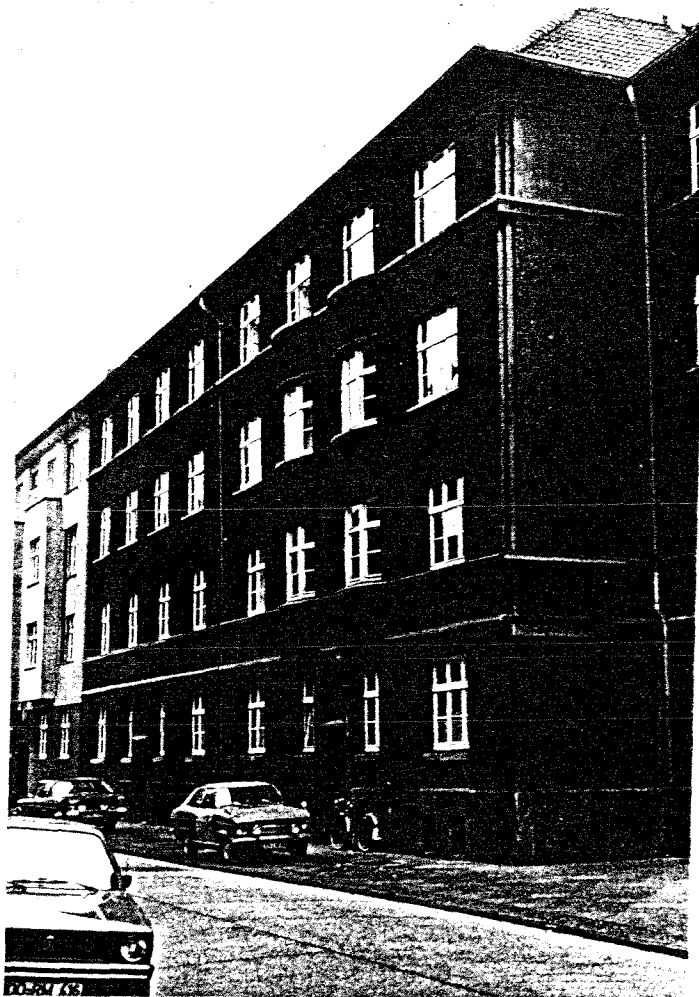
Abb. 21: Ansicht der Häuser Unnaerstr. 27 und 29 vor dem Umbau
