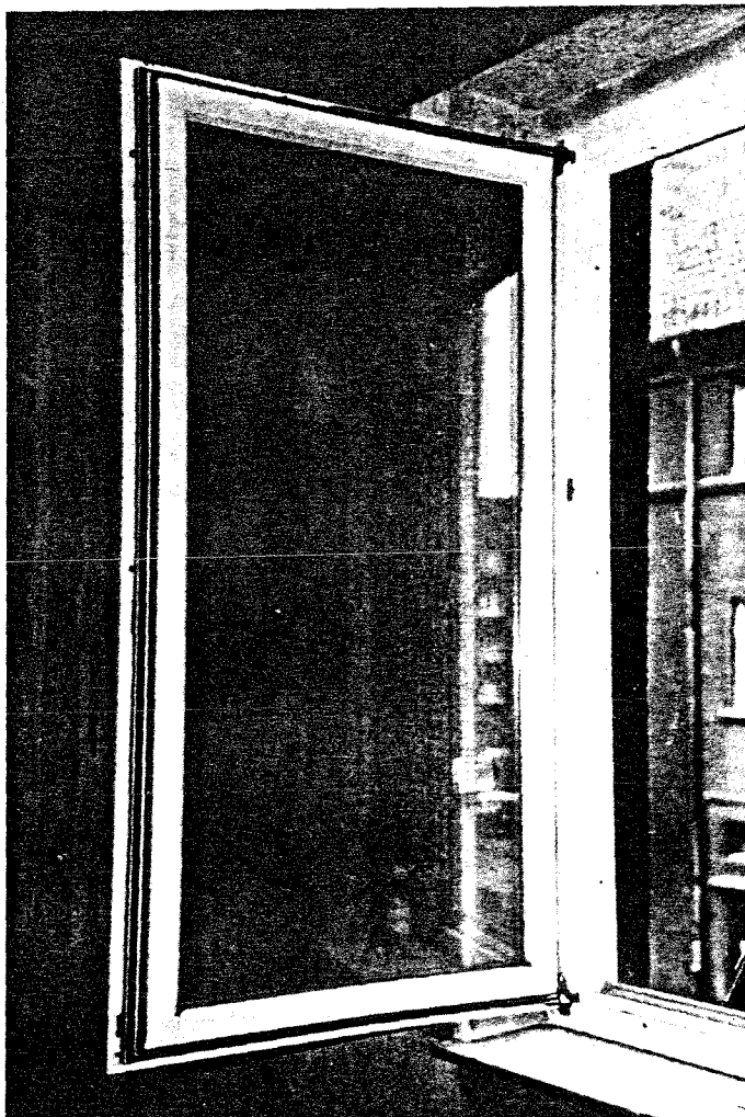
Abb. 34: Schallschutzfenster (Schallschutzklasse 4) mit doppelt umlaufender Dichtung
