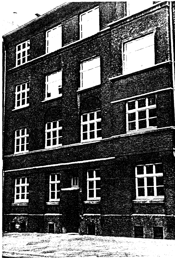
Abb. 20: Ansicht des Hauses Unnaerstraße 25 vor dem Umbau
