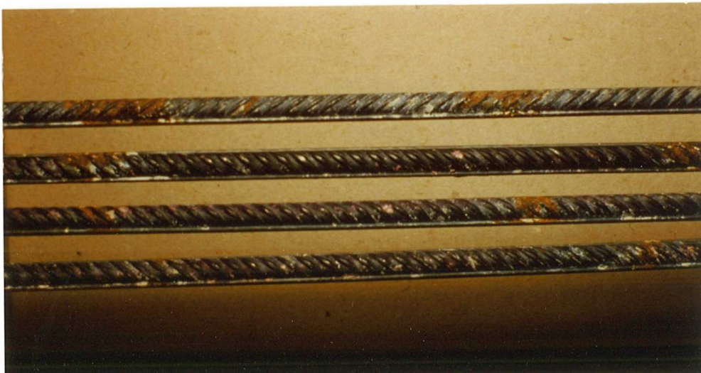
Bild 16: Beispiele für die Rostgrade Ro1 bis Ro4
