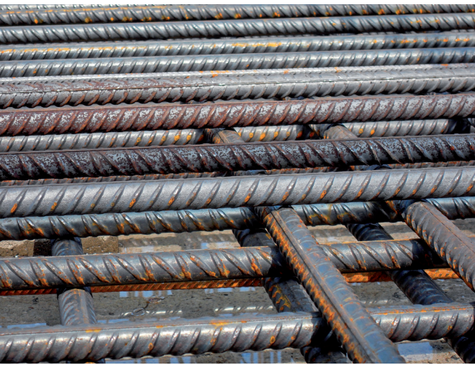
Bild 6: Wenige Positionen, aber jede mit einer hohen Stückzahl, in einem einfachen Plattengeflecht
