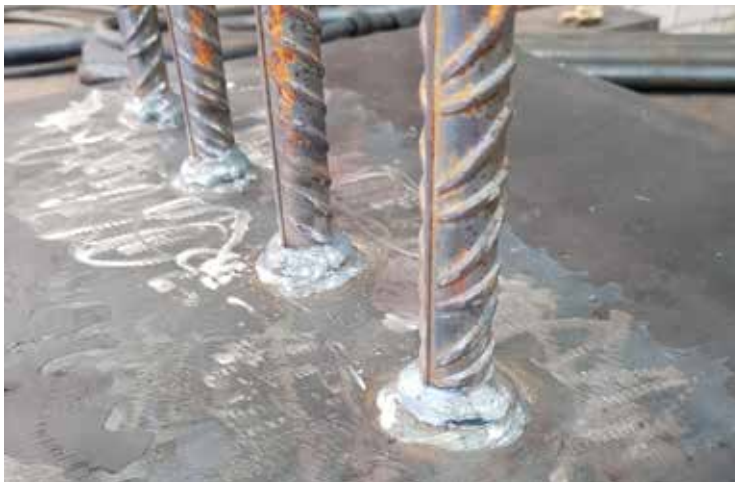
Bild 22: Beispiel für eine geschweißte Stirnplattennah
