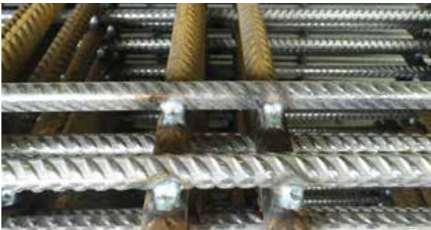
Bild 15: Beispiel für einen manuell geschweißten Kreuzungsstoß
