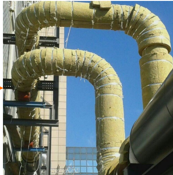
Isolierte Rohrleitung
