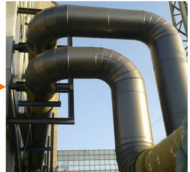
Blechhülle zum Schutz der Dämmung
