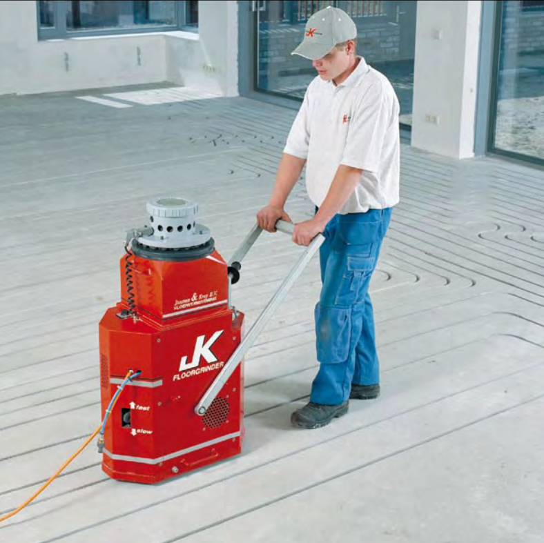
Der patentierte „Floorgrinder“ fräst mittels eines Industriediamanten die Rillen für die Heizungsleitungen.
