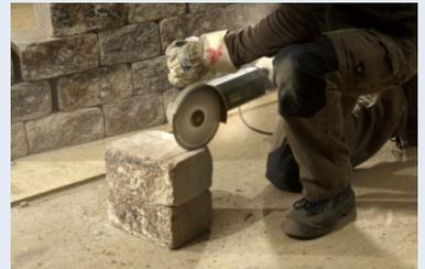
Glatte Schnittkante mit Trennschleifer oder Nassschneide-Gerät
