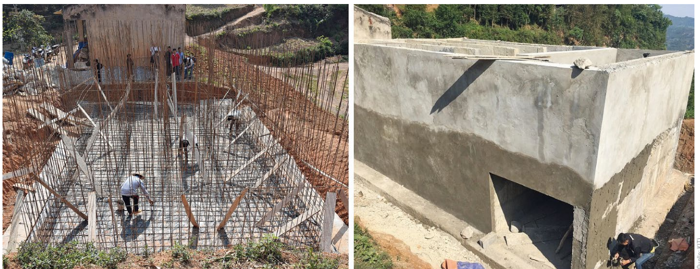
Bild 14 Bauarbeiten am zentralen Verteilbehälter (links: März 2017, rechts: Juni 2017) Construction of the centralized distribution tank (left: March 2017, right: June 2017)
