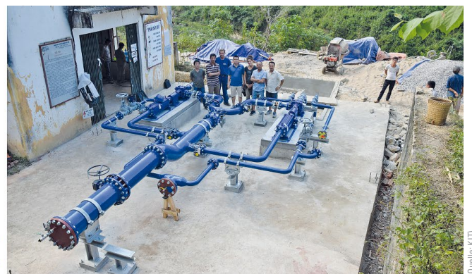
Bild 5 CAD-Modell eines Wasserfördermoduls mit MTC 65/2 6.1 als PAT und MTC 50/12 4.1 als Förderpumpe (links), Installation des Pilotsystems an der Hochdruckanlage Seo Ho CAD model of a water supply module with MTC 65/2 6.1 as PAT and MTC 50/12 4.1 as feed pump (left), installation of the pilot system at the high-pressure plant Seo Ho
