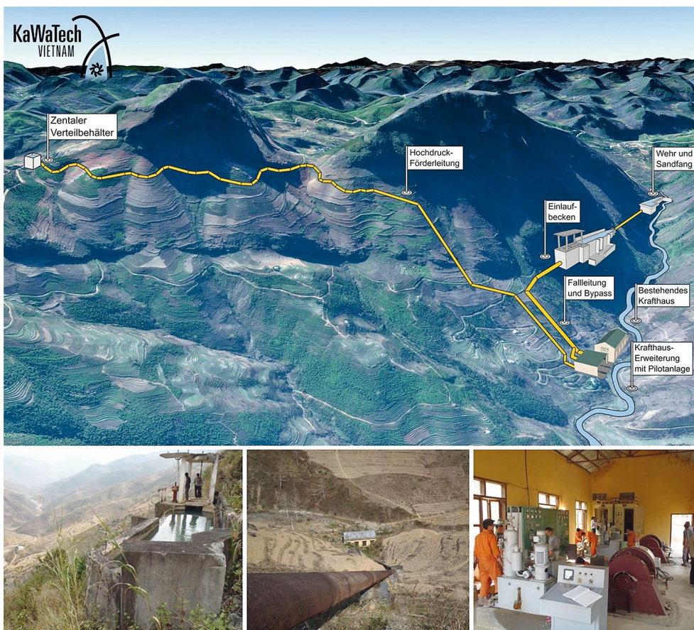
Bild 3 Infrastruktur der Hochdruckanlage Seo Ho und des innovativen Wasserfördersystems (oben), Einlaufbecken, Fallleitung und Krafthaus vor Beginn der Implementierungsphase (unten) Infrastructure of the high-pressure plant Seo Ho and of the innovative water supply system (top), inlet pool, penstock and powerhouse prior to the implementation measures (bottom)
