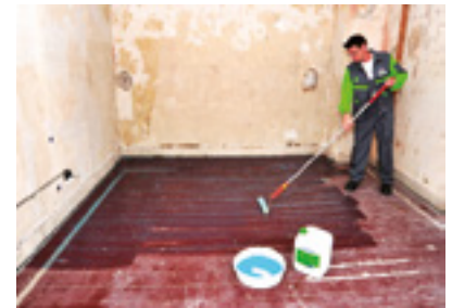
Grundierung einer Holzfläche mit KÖSTER VAP I 06 Primer
