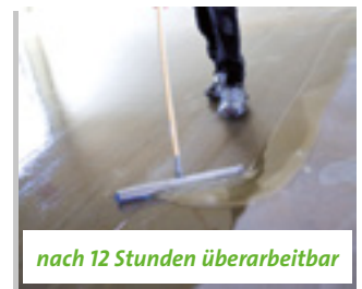
nach 7 Tagen auf frischem Beton einsetzbar
