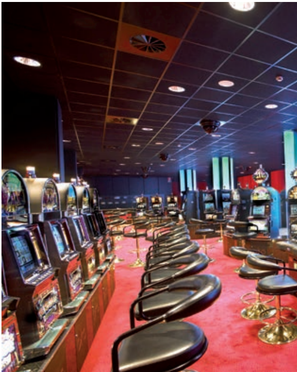
Radialauslass mit quadratischer Sichtfläche in einem Spielkasino
