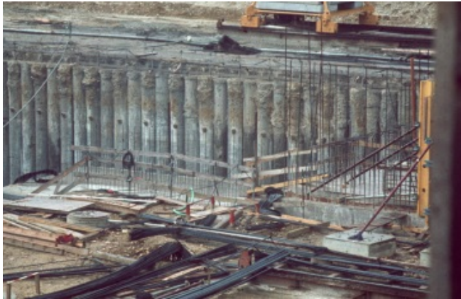
Abbildung 36: Bohrpfahlwand mit einer Ankerlage
