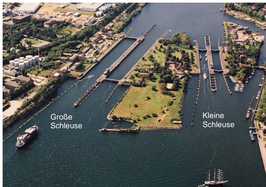
Abbildung 4: Schleusenanlage Kiel (Ansicht in Richtung Westen)
