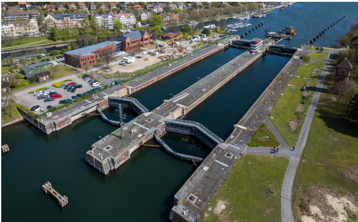
Abbildung 10: Kleine Schleuse mit Blickrichtung auf die Schleuseninsel Nord
