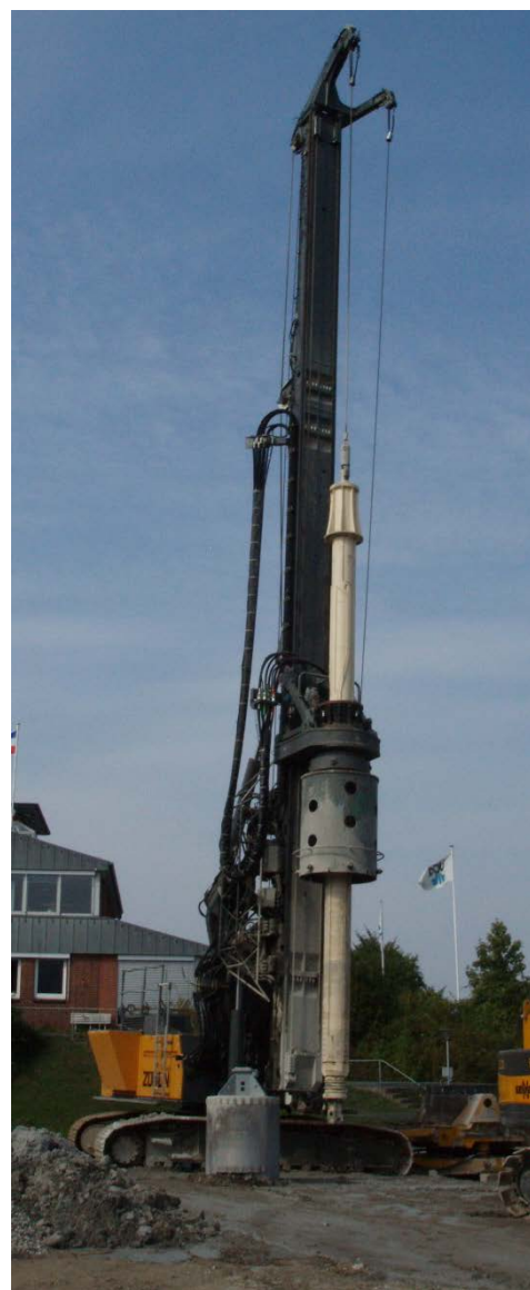
Abbildung 34: Großpfahl-Drehbohrgerät
