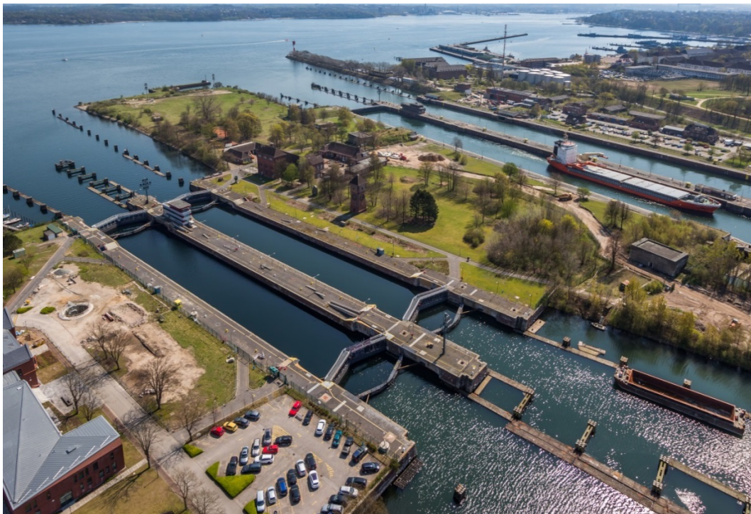
Abbildung 11: Kleine Schleuse mit Blickrichtung auf die Schleuseninsel Süd (Mittelinsel)
