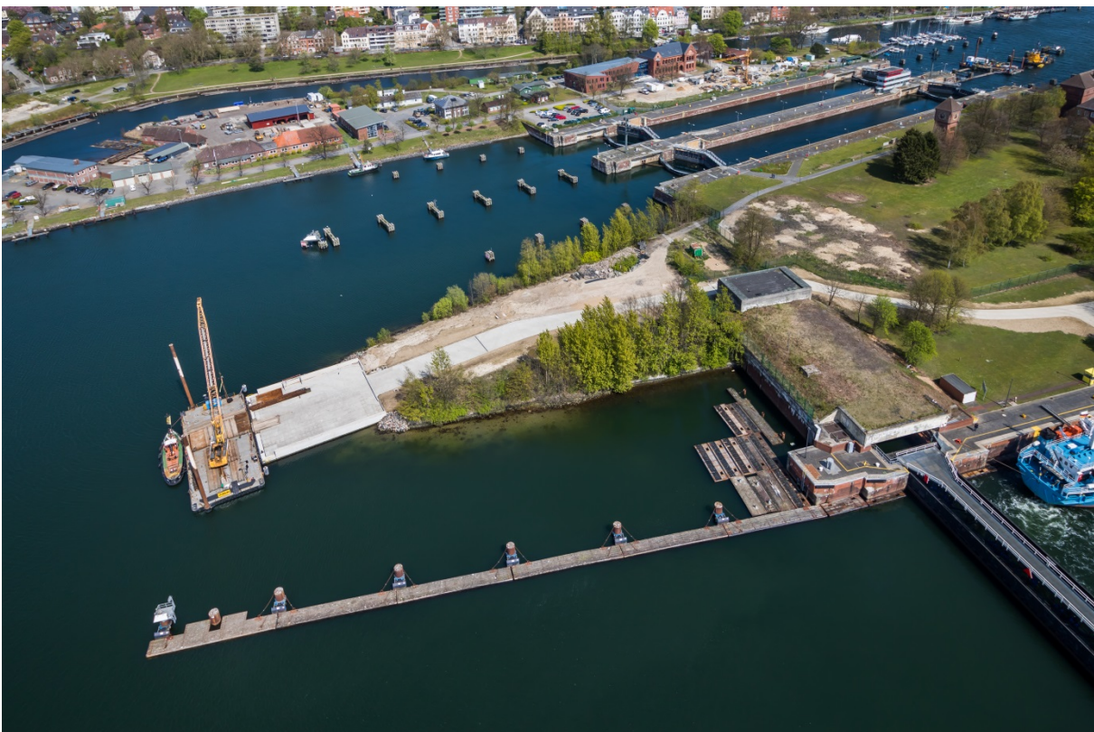
Abbildung 14: Umschlagstelle auf Schleuseninsel Mitte
