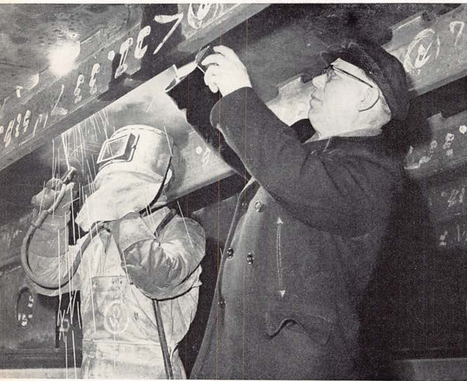
► Qualifizierte Schweißer müssen den Hintersteven in genauer Schweißfolge verschweißen. Meister Nowaczyk bespricht die Schweißfolge mit Schweißer Nötzel.
