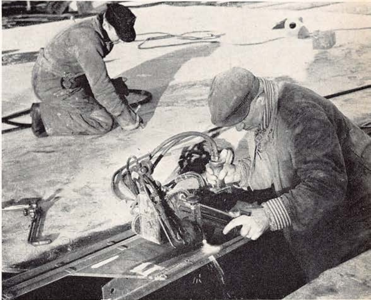
Alle Brennschnitte führen unsere Brenner mit transportablen Maschinen aus. Brenner Nowack und Behauer Hildebrandt bei ihrer Arbeit.
