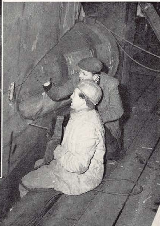
◀ Meister und Kontrolleure überprüfen die Güte der Arbeitsausführung. Meister Eisermann und Schweißer Reiter.
