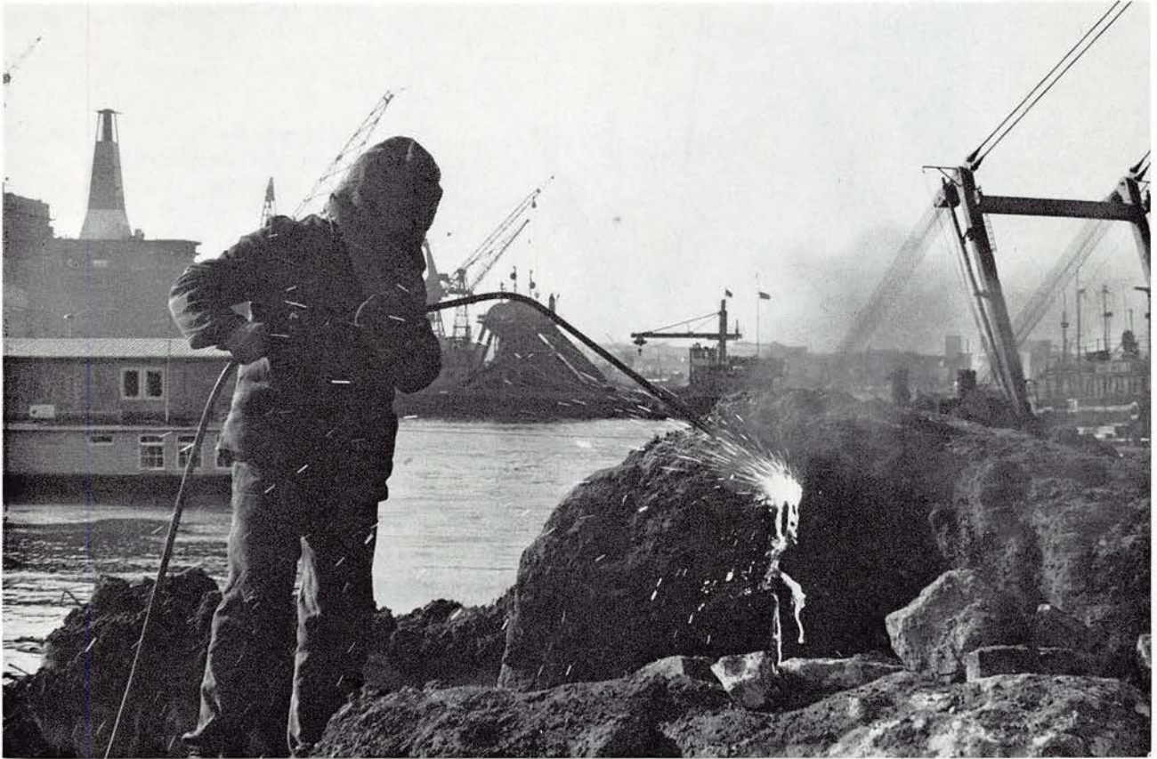
▲ Die vom Schwimmkran „HEBE I“ vom Molengrund gerissenen Betonbrocken werden von einer Sauerstofflanze zerschnitten.
