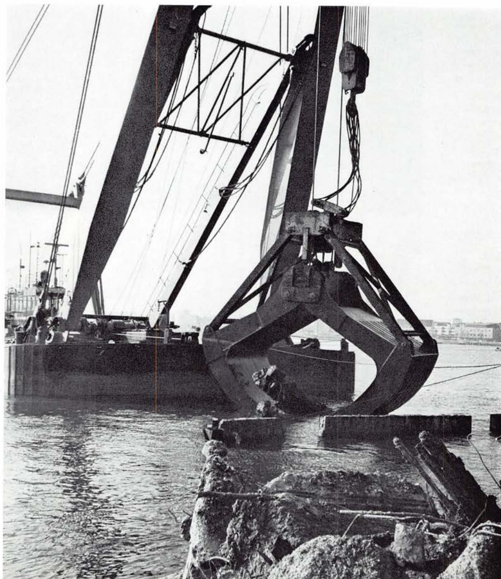
Schwimmkran beim Abtragen von Molen- trümmern vor der Arsenalkaje.
