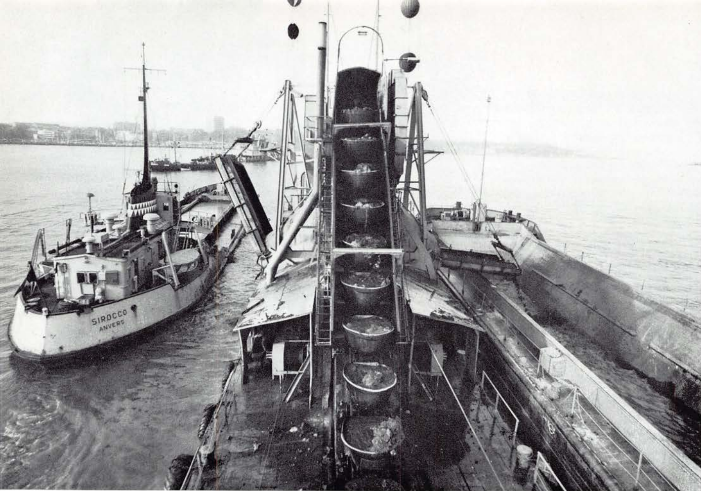
13 selbstfahrende Schuten und zwei Schleppschuten machen bei einem Umlauf von etwa 3 1/2 bis 4 Stunden bei einer Geschwindigkeit bis zu 10 Seemeilen in der Stunde etwa 40 Reisen zur Kolberger Heide.
