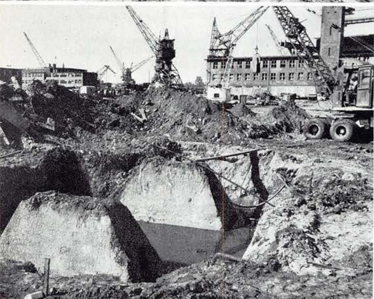
Abbruch des Magazingebäudes (31. 7. 1973), Beseitigung von Ausschachtungshindernissen (Mitte September 1973) und Beginn der Ausschachtungsarbeiten (5. 12. 1973). Die ersten Auflager stehen (7. 12. 1973).
