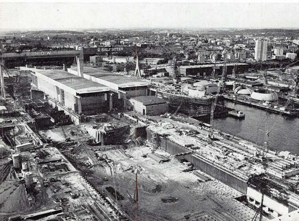
Beim Ausdocken des Neubaus Nr. 76 am 14. Juni 1975 erfolgte die letzte Durchfahrt eines Schiffes durch die schmale Öffnung des provisorischen Baugrubenabschlußdammes.
