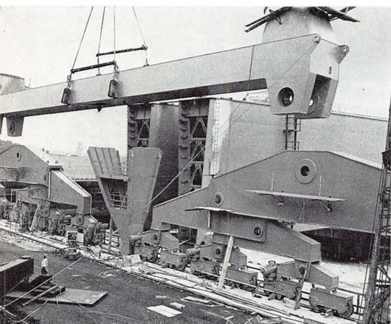
Gleichzeitig wurden die beiden Pendelstützenrohre, die von der SASTA in Mönkeberg zusammengeschweißt worden waren, zum Hochziehen vorbereitet.
