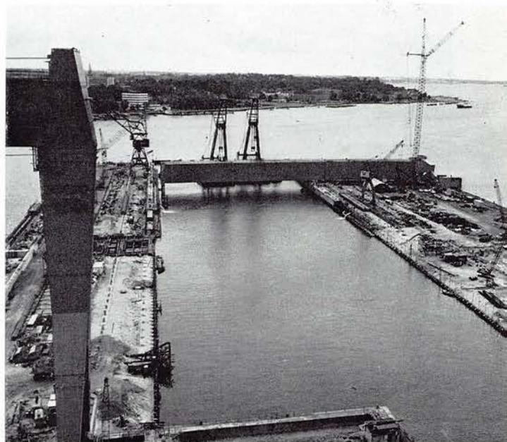
Anschließend wurde das Brückenträgerteil 3 eingeschwommen und an das bereits über dem Vorhafen liegende Teil 1 angepaßt.
