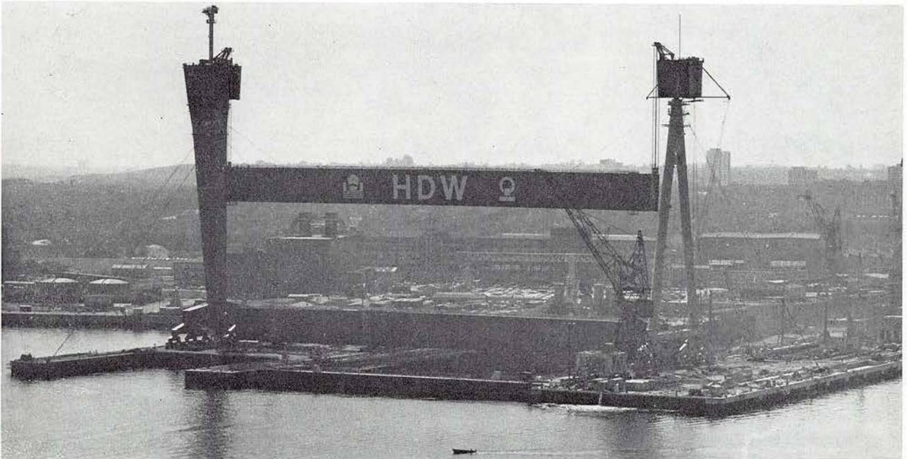
▲ Am 15. 8. 1975 begann das Ziehen des Brückenträgers mit Hilfe von 4 Winden à 25 t Zugkraft. Durch Einscheren der Flaschenzüge wurde insgesamt eine Zugkraft von 1200 t erreicht.
