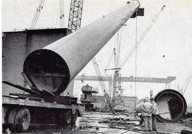
Bei der Montage der Pendelstütze am 18. 7. 1975 wurde das erste der ca. 65 m hohen und 100 t schweren Pendelstützenrohre mit dem Autokran einseitig angehoben, wobei die gegenüberliegende Seite mit Hilfe eines Tiefladers nachgeführt wurde.
