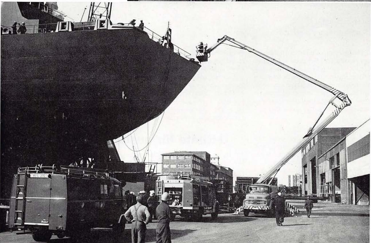
Bei dem für das Werk Gaarden beschafften Skylift handelt es sich um einen Speziallastwagen, auf dessen Chassis ein mehrgliedriger Ausleger mit einer Arbeitsplattform montiert ist. Das Chassis wird für den Einsatz am Arbeitsort mit Hilfe von vier ausfahrbaren Beinen abgestützt. Sodann kann die von einem Geländer gesicherte Arbeitsplattform bis zu einer Höhe von
