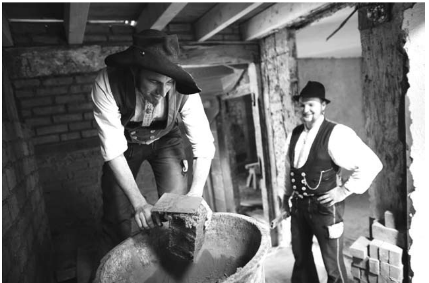
Lehmbaukurs im Zentrum für Restaurierung und Denkmalpflege Herrstein
