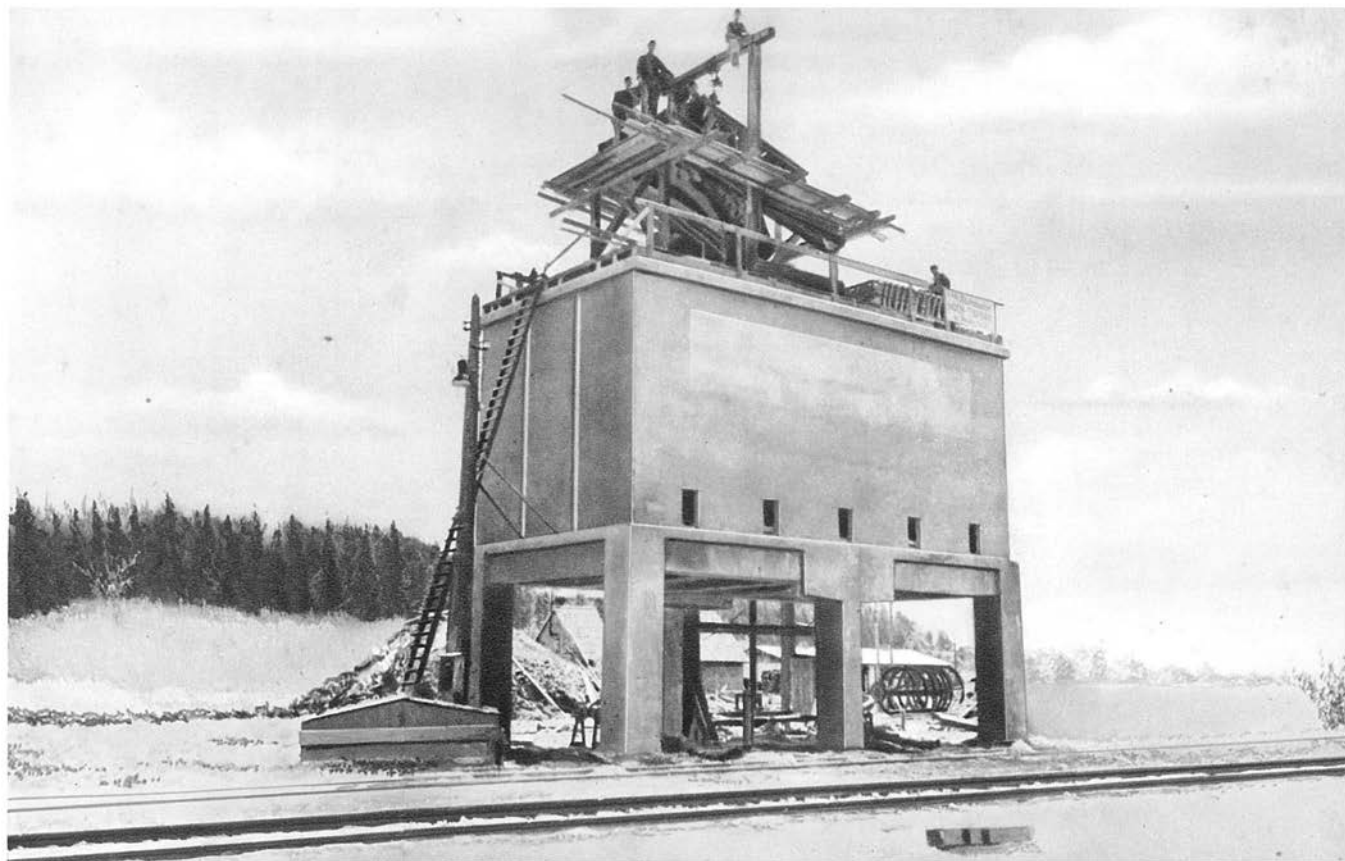
Kieswäsche im Bau
