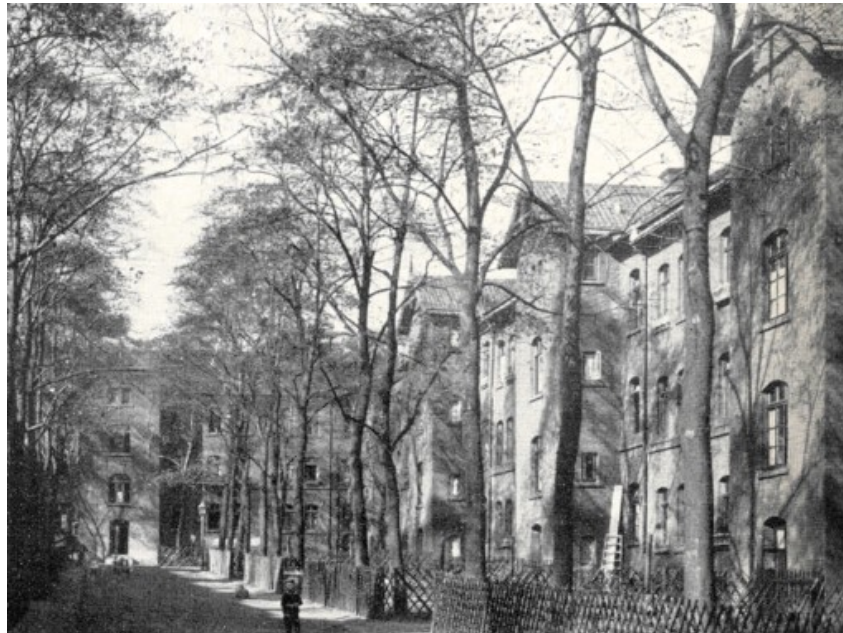
7 Arbeiterkolonie Cronenberg, historisches Photo, 1872-74, Essen
