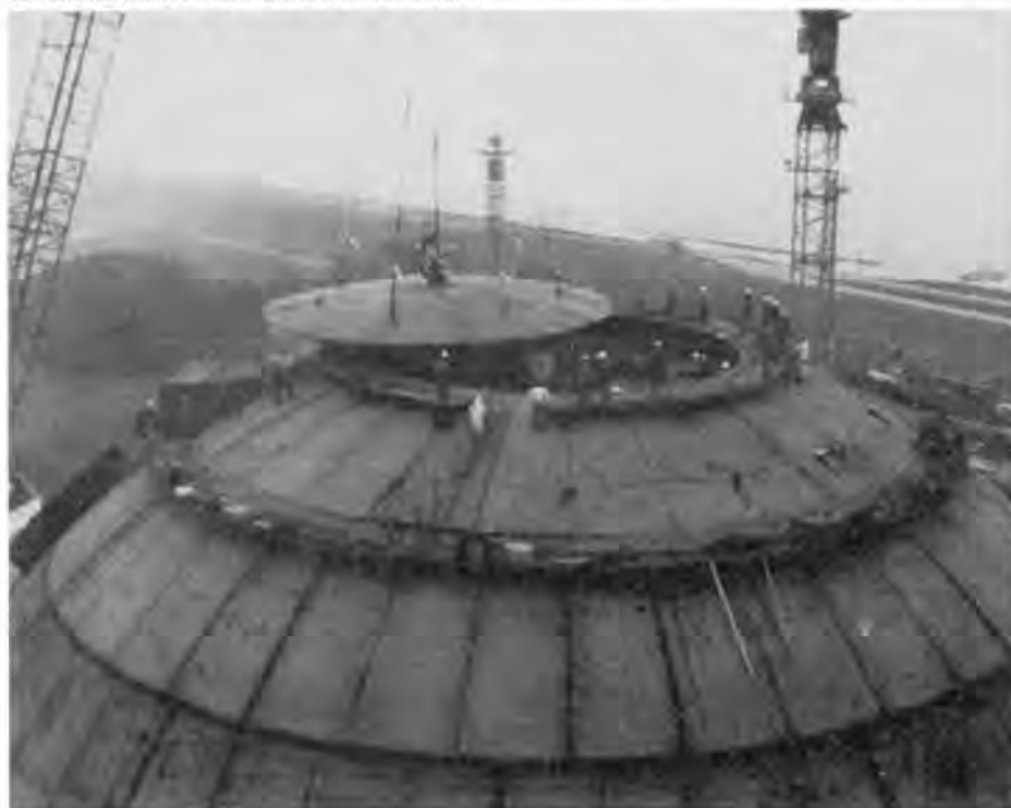
Kernkraftwerk Brokdorf. Schließen des kugelförmigen Sicherheitsbehälters
