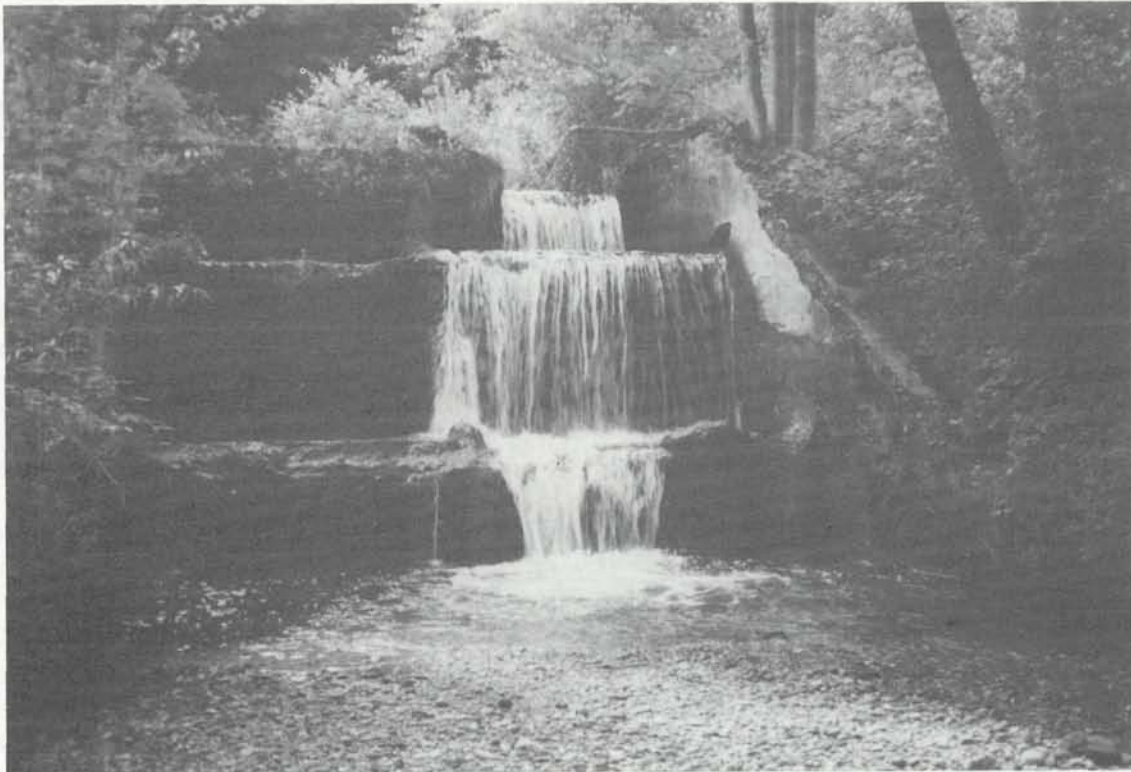
Abb. H 7: Aufgelassenes Wehr, das die Aufwärtswanderung von Gewässerorganismen verhindert (Foto von Dr. Renate Pucsko).
