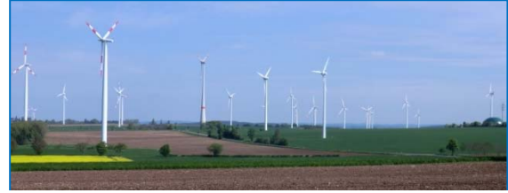
Abb. 4: Windpark Kesfeld – Heckhuscheid
