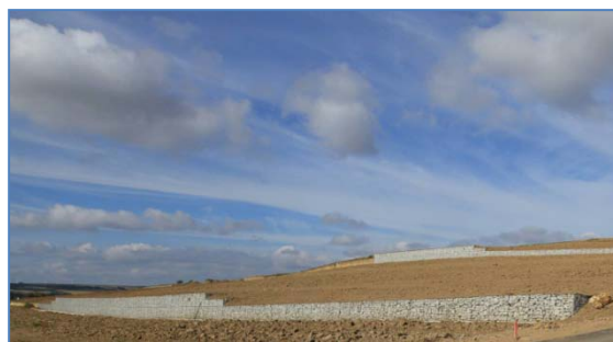
Abb. 3: Neu gebaute Weinbergsmauern
