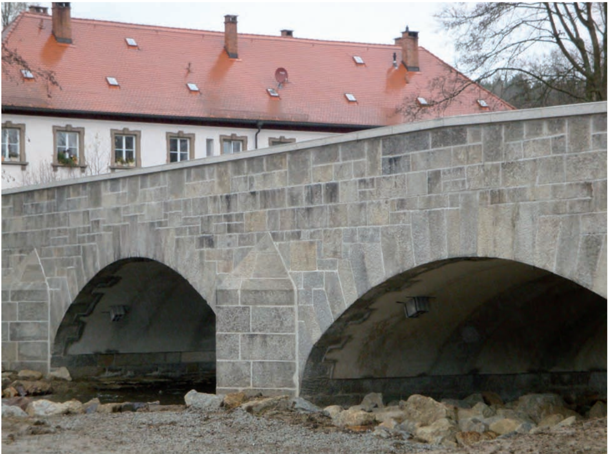
Abb. 224: Markgrafenbrücke in Kaiserhammer
