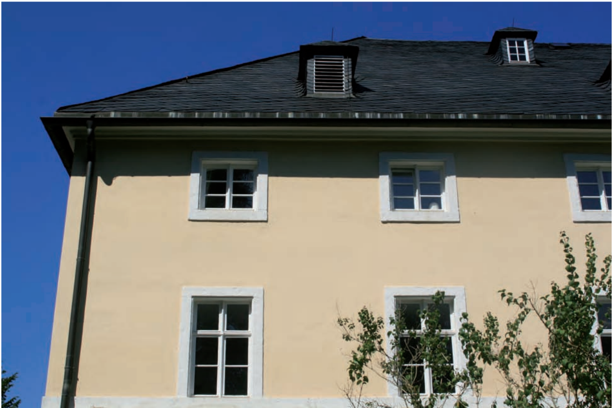
Abb. 186: Lamellenfenster im Alten Kurhaus in Bad Alexandersbad
