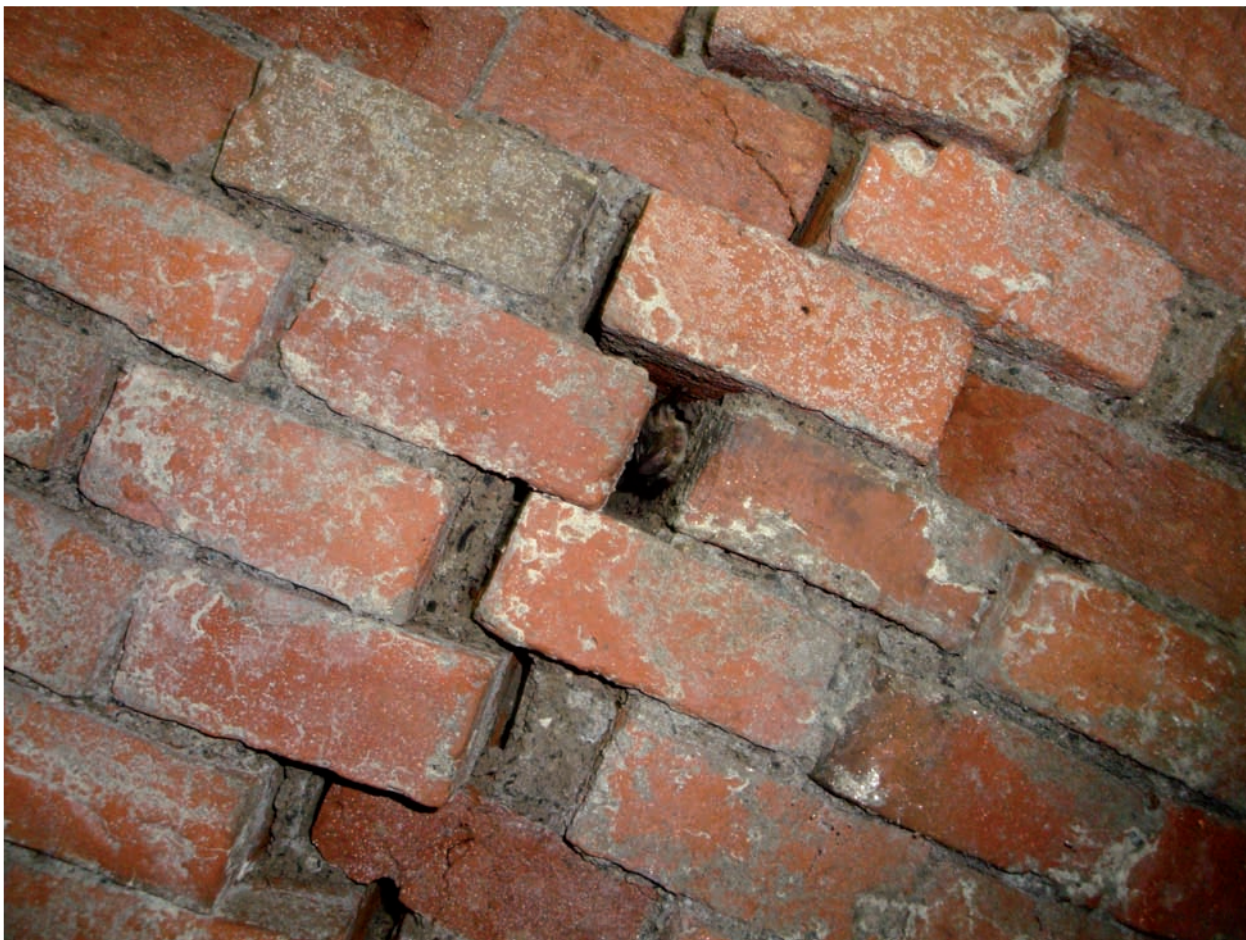
Abb. 69: Braunes Langohr im Ziegelgewölbe in Arzberg
