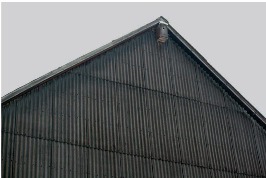
Abb. 42: Wellplattenverkleidung
