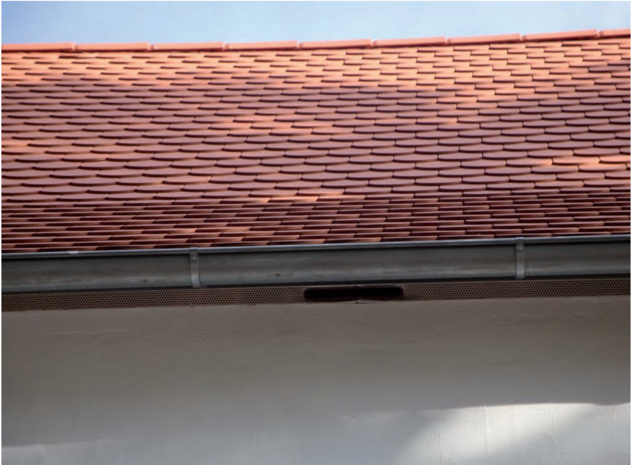
Abb. 210: Einflug in das Dach des Hammerherrngutes, Leupoldsdorf
