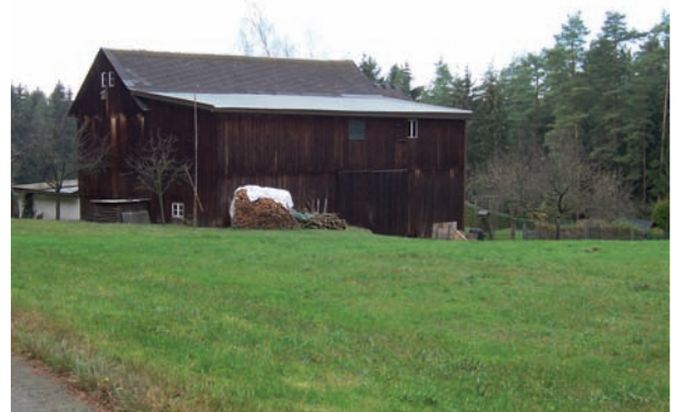
Abb. 104: Das Quartier der Bartfledermaus befindet sich hier nicht hinter den hellen Stellen der Holzverschalung, sondern dem oberhalb hängenden Starenkasten (unter den Fenstern)
