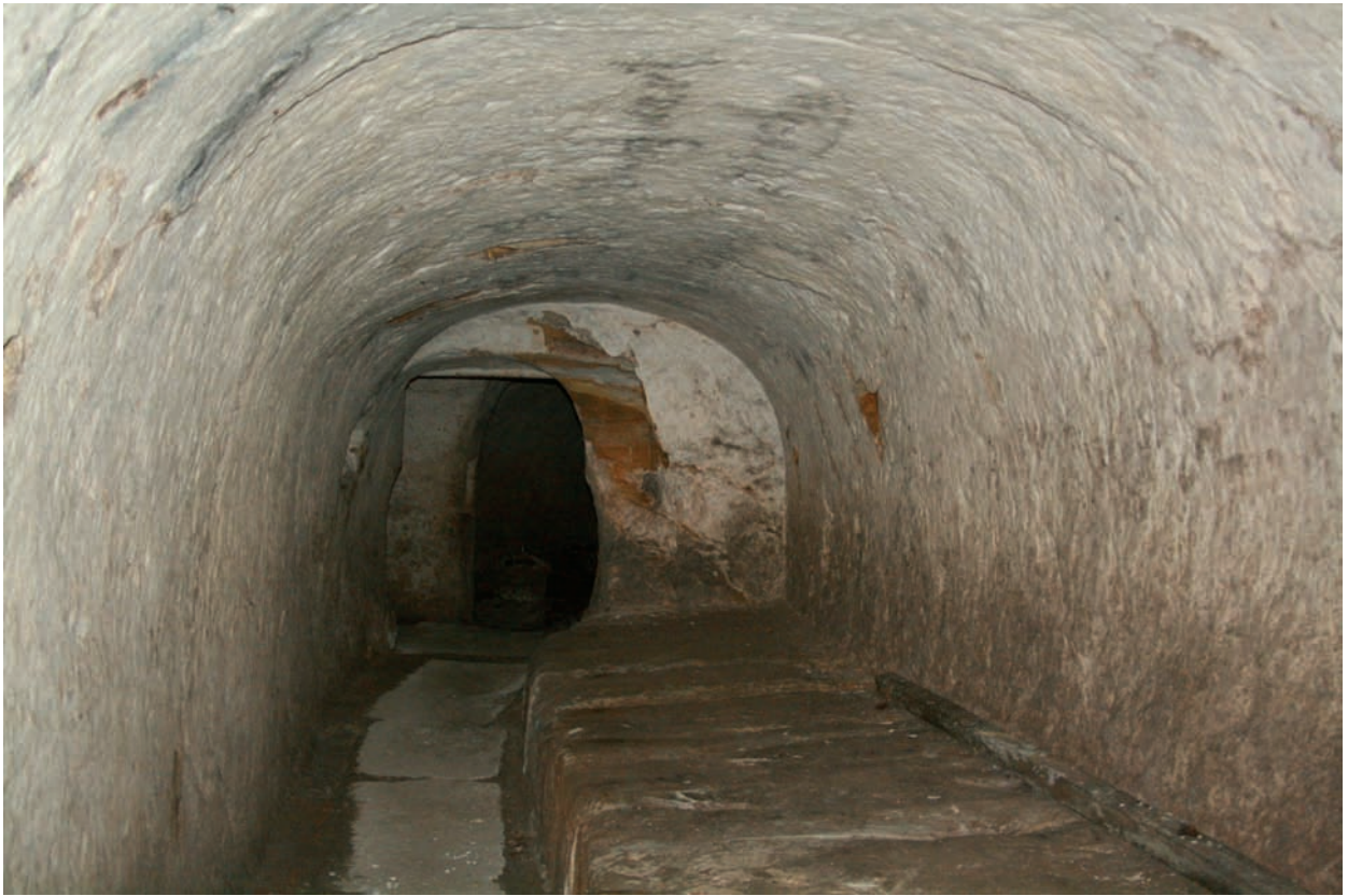
Abb. 65: Keller in der Kellergasse, Katharinenberg
