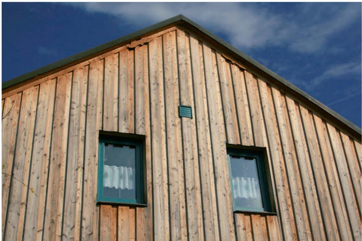
Abb. 219: Spaltenquartier an einer Garage in Schönbrunn, Einflüge im Giebelbereich
