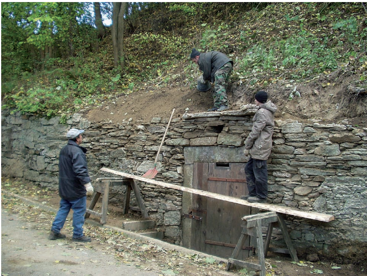
Abb. 230: Kellersanierung durch den Landschaftspflegeverband und den ABM-Trupp "Jugendliche im Umweltschutz"
