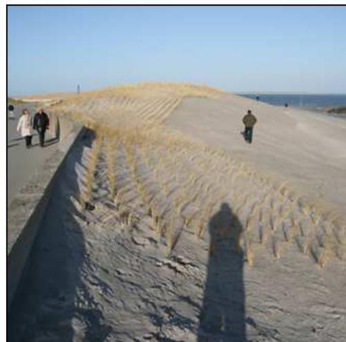
Die mit Sand aus der Nordsee aufgeschüttete Düne sichert den Hochwasserschutz von List. Der Sand wird teilweise durch Abtrag ins Wattenmeer verlagert und trägt dort zum Ausgleich des Sedimentdefizites bei.
