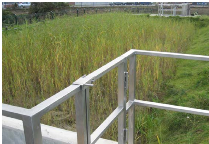
Bild 2-5: Blick über den Bodenfilter von der Vorstufe zum Ablaufbauwerk
