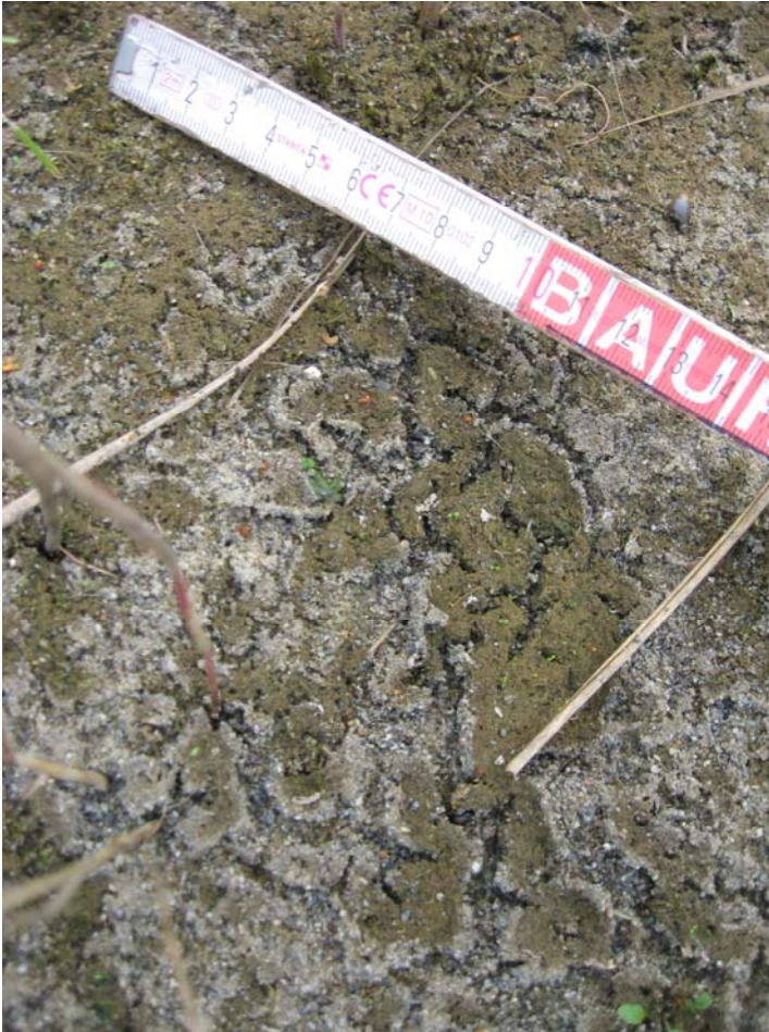
Bild 3-6: Filteroberkante Bereich Ablauf vor Inbetriebnahme
