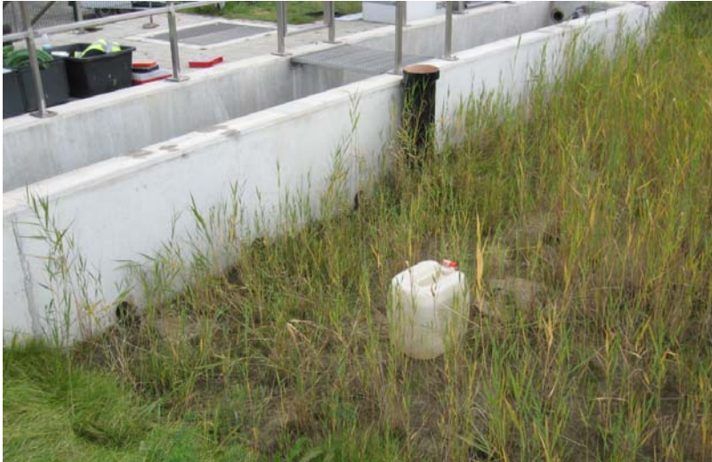
Bild 2-6: Blick auf die Vorstufe mit der Abflussverteilung (7 DN 100) und dem Standrohr für den Anschluss des Dränsammlers
