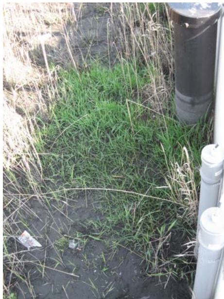
Bild 3-13: Fremdbewuchs auf der Filteroberfläche (19.04.2011)
