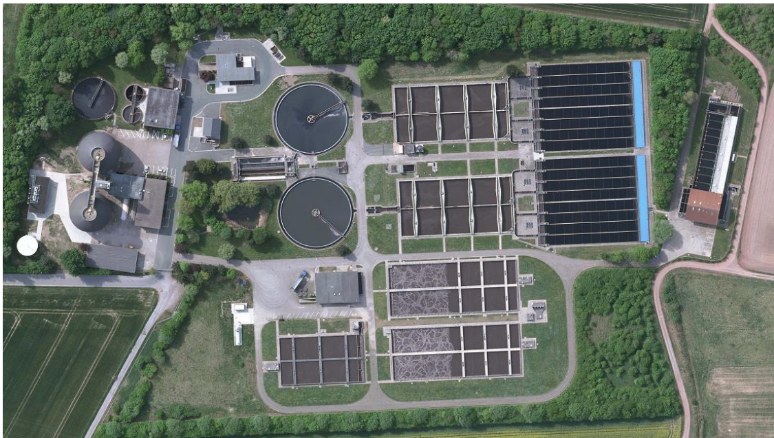
Abbildung 1: Luftbild Kläranlage Minden
