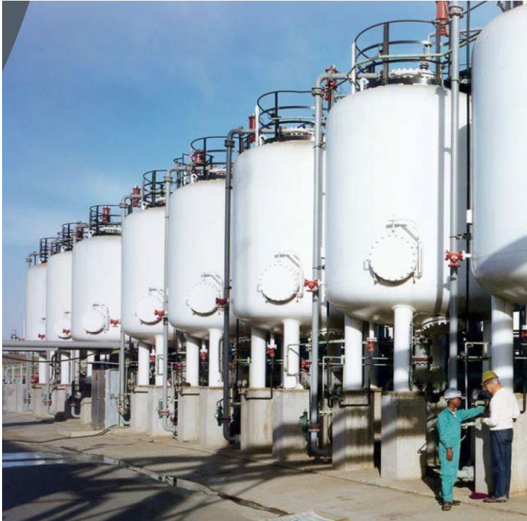
Abbildung 13: Druckbehälter-Kornaktivkohle (Firmeninformation Donau Carbon)
