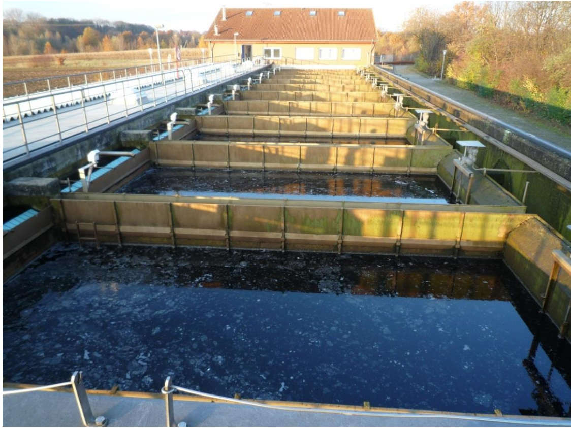
Abbildung 3: Flockungsfiltration Minden, abwärtsdurchströmte Filterkammern
