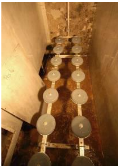
Abbildung 18: Kontaktreaktor mit Ozondiffusoren aus Keramik
