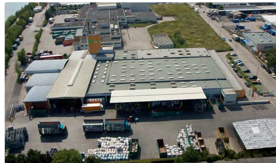
Abfall-Logistikzentrum in Wels
