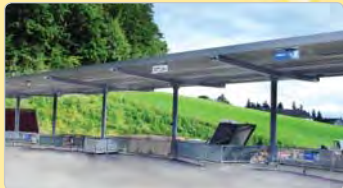
ASZ Rohrbach, BAV RO
