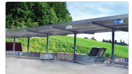
ASZ Rohrbach, BAV RO
