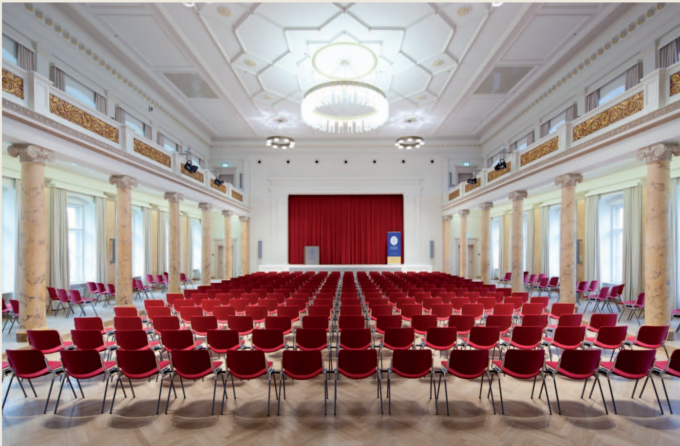
Abb. 52 Festsaal mit eingebauter Sprinkleranlage
