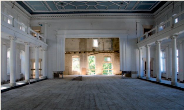
Abb. 26 Blick in den Festsaal während der Sanierung
