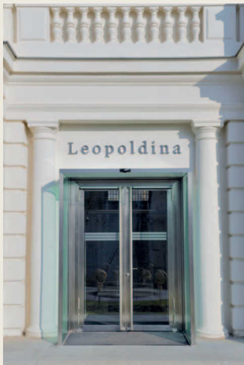
Abb. 45 Zustand nach Sanierung
