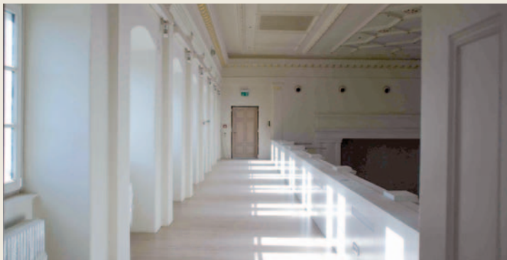
Abb. 91 Verkofferung der Brüstung nach Fertigstellung
