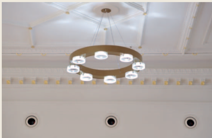
Abb. 57 Detail der Lüftungsöffnungen im Festsaal
