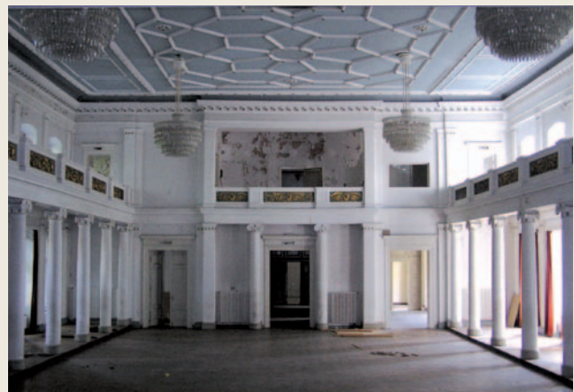
Abb. 19 Blick in den Festsaal vor Sanierung
