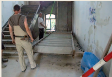
Abb. 83 Ausbau und Zerlegen der Treppe
