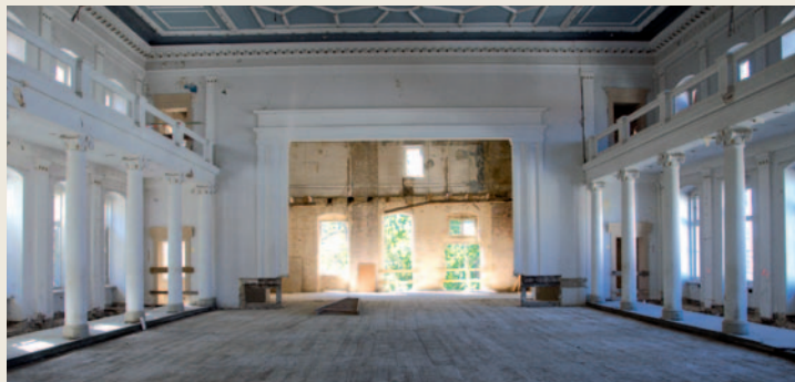
Abb. 101 Blick in den Festsaal mit weißen Säulen vor Sanierung
