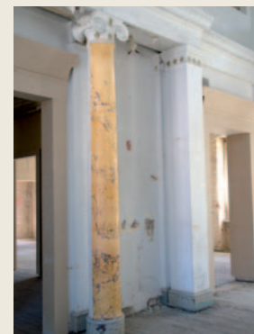
Abb. 103 und 104 Säulen während der Sanierung
