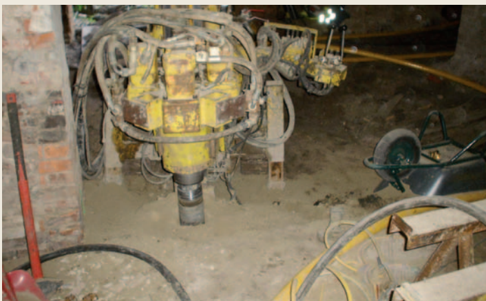
Abb. 70 Gerät zum Einbringen der Mikropfähle
