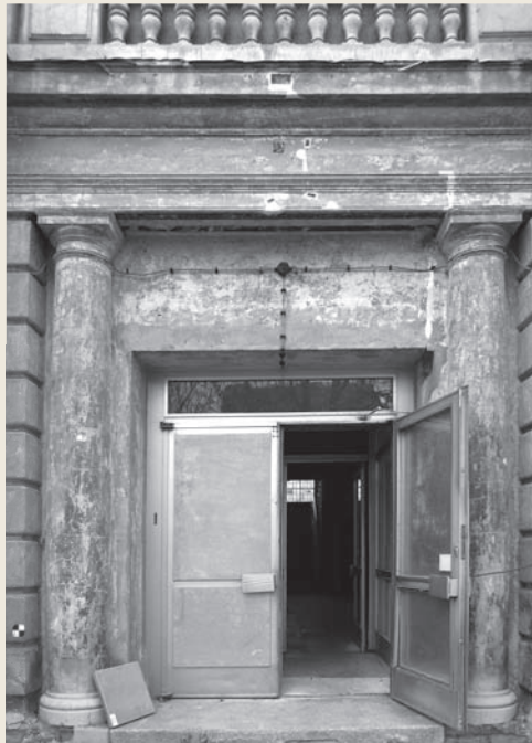
Abb. 43 Zustand vor Sanierung
