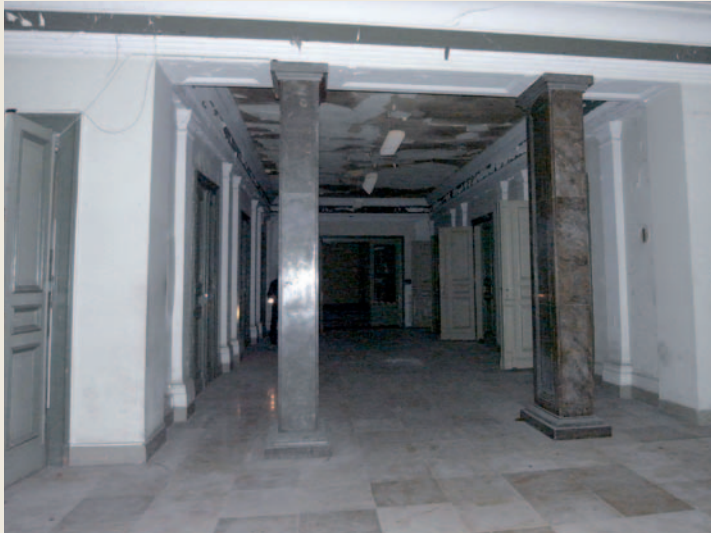
Abb. 46 Zustand vor Sanierung
