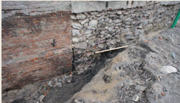
Abb. 72 Detail Kelleraußenwand vor Sanierung
