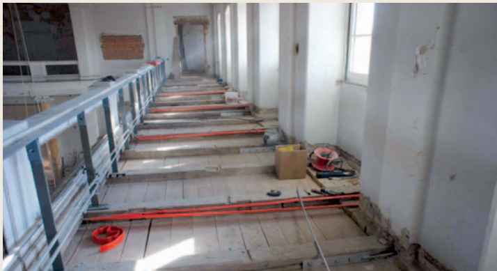
Abb. 90 Brüstung vor Verkofferung von der Empore aus
