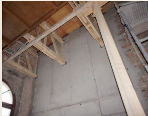
Abb. 79 Fertige Stahlbetonwand
