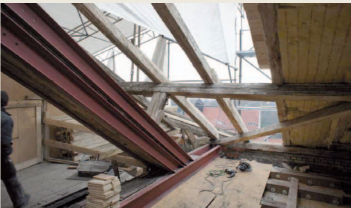
Abb. 99 Dachträger aus Stahl
