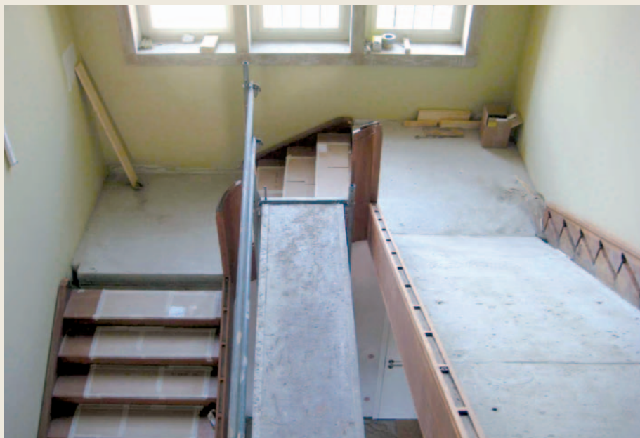
Abb. 86 Erste Treppenelemente wieder eingebaut
