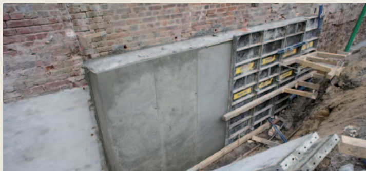
Abb. 73 Stahlbetonvorsatzschale vor Kelleraußenwand
