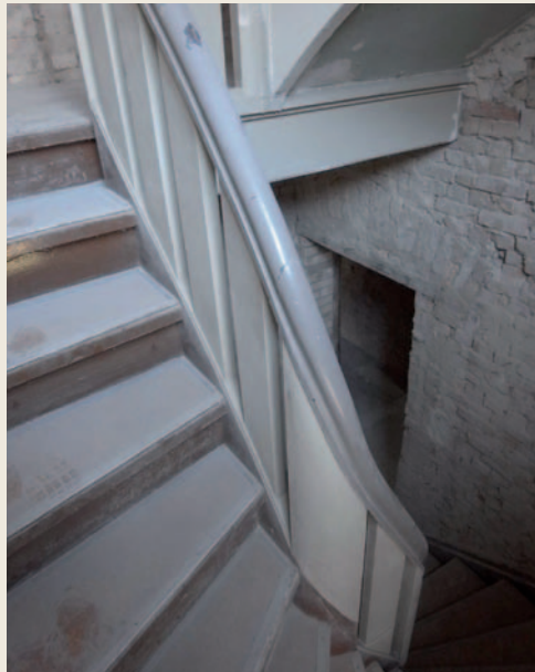
Abb. 93 und 94 Treppengeländer im Verwaltungsbereich vor Sanierung
