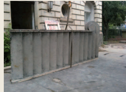
Abb. 84 Abtransport zur Sanierung
