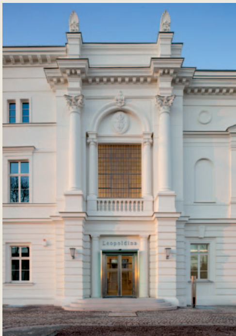
Abb. 40 Eingangsbereich nach Sanierung
