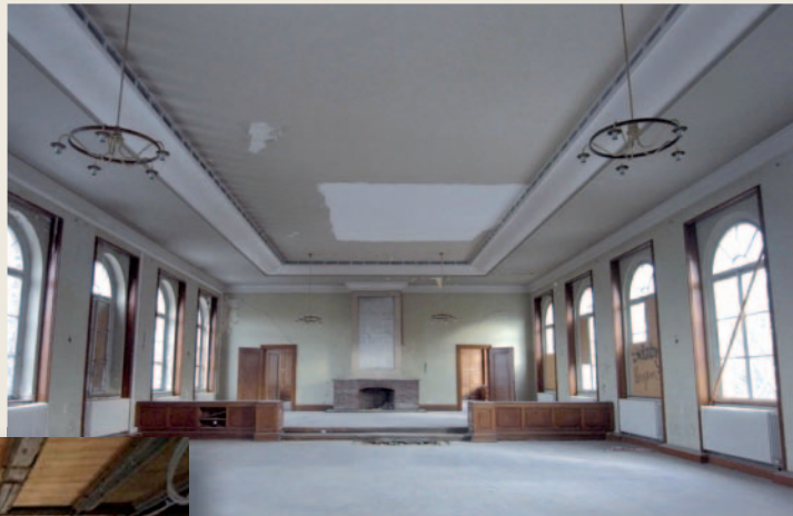
Abb. 54 Vortragssaal vor Sanierung
