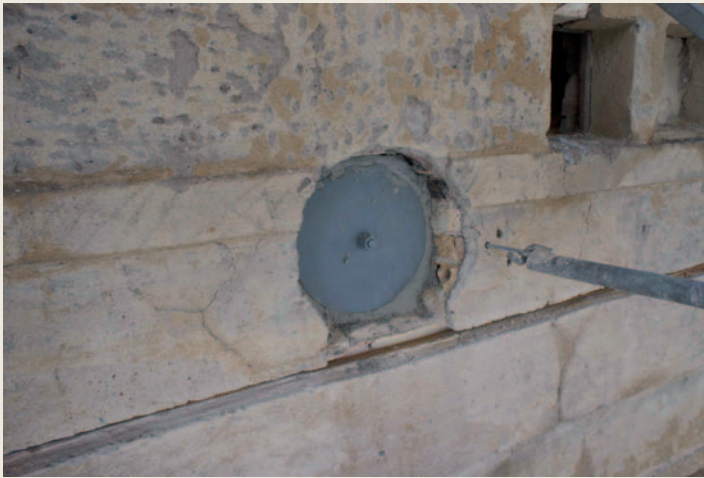
Abb. 74 Ankerplatte zum Verschnüren, darunter liegend ist ein Spannanker zu sehen
