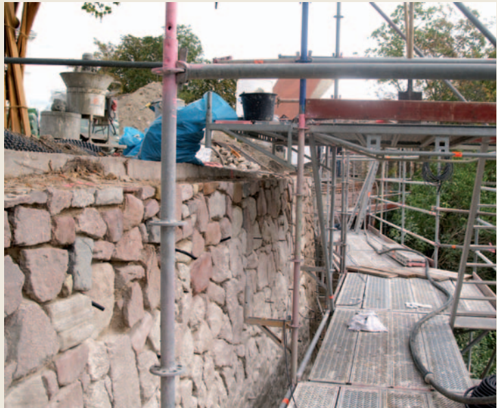
Abb. 110 Neue Betonstützmauer, verkleidet mit Steinen aus dem Altbestand
