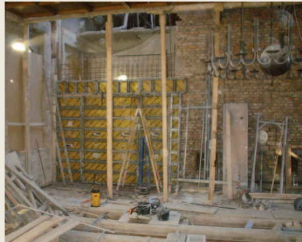
Abb. 78 Die Stahlbetonwand mit Verschalung
