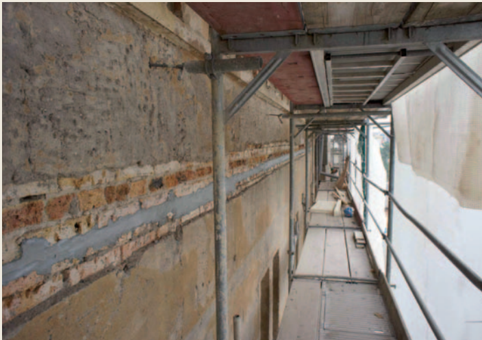
Abb. 75 und 76 Die Spannanker umfassen den gesamten Außenbereich
