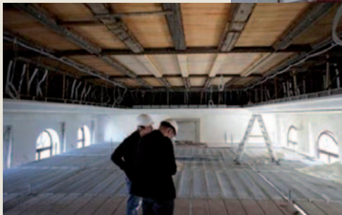
Abb. 55 Nach Deckenausbau
