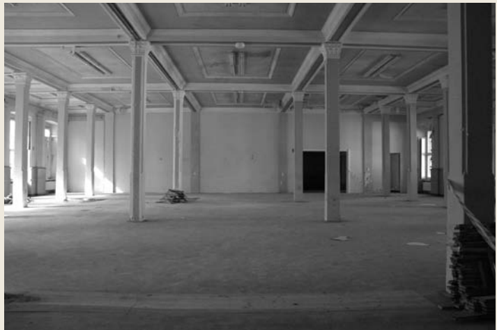
Abb. 36 Aufenthaltsraum/Mensa vor Sanierung
