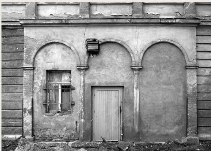
Abb. 33 Zustand vor Sanierung
