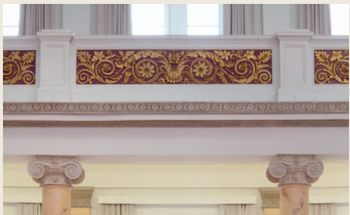
Abb. 38 Detail der Empore und der Stuckkapitelle im Festsaal nach Sanierung
