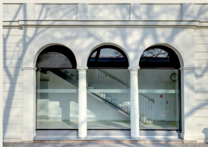
Abb. 35 Zustand nach Sanierung
