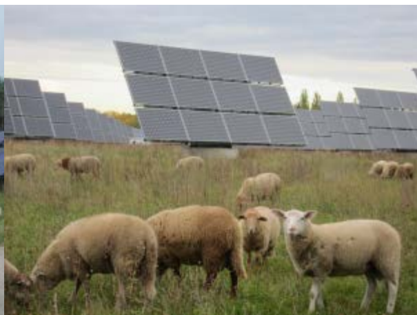
Abbildung 2: PV-Anlage mit Movern bzw. Trackern (Foto: Solon Energie GmbH in SCHALOW 2013).
