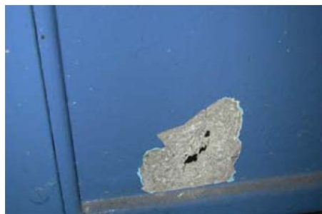
Abb. 4: Asbestzement-Trennwand
