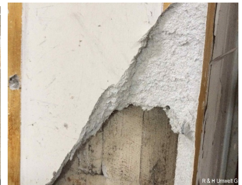
Abb. 3: Ausgebrochene Promabestverkleidung
