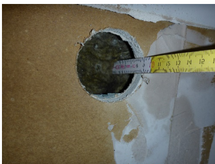
Abb. 13: Asbesthaltige Gipskartonspachtelmasse
