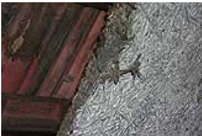
Abb. 18: Heraklithplatte im Dachbereich
