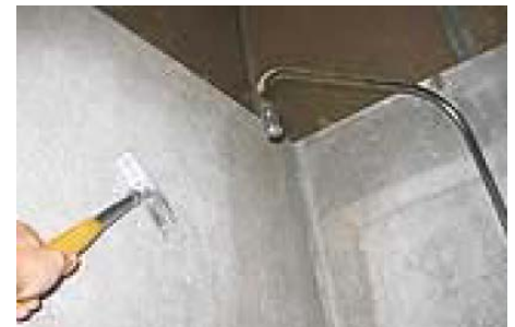
Abb. 6: Asbestzementplatte als Abtrennung einer Duschkabine
