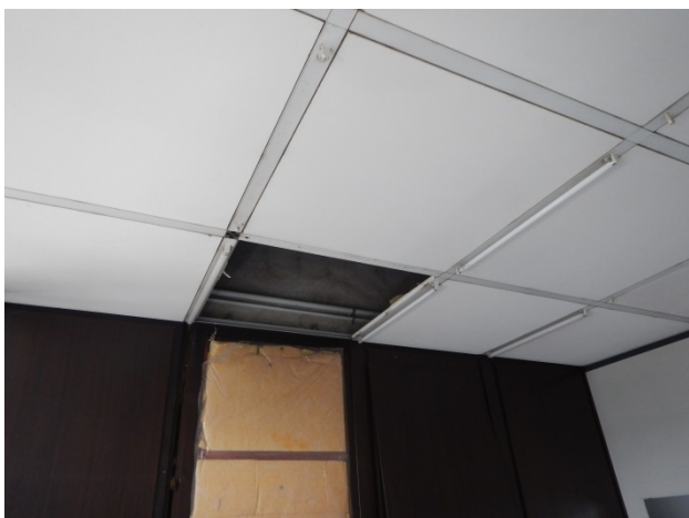
Abb. 16: PCB-haltige Deckenplatten
