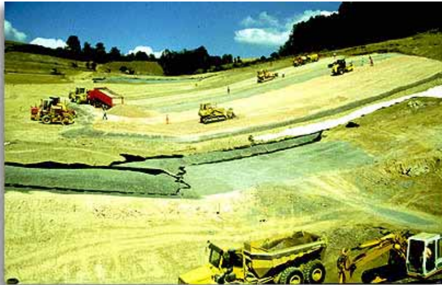
Herstellung einer mehrfachmineralischen Basisabdichtung für eine Hausmülldeponie. Die einzelnen Lagen aus tonigen und gemischten Dichtbaustoffen sind an den unterschiedlichen Farben erkennbar.
