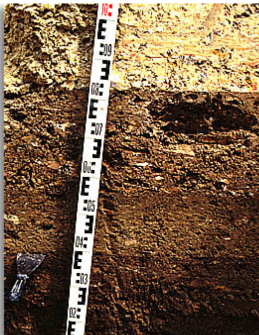
Kompensationsschicht (untere dunkle Lage) mit multimineralischer Deponiebasisabdichtung (mittlere und obere Lage)
