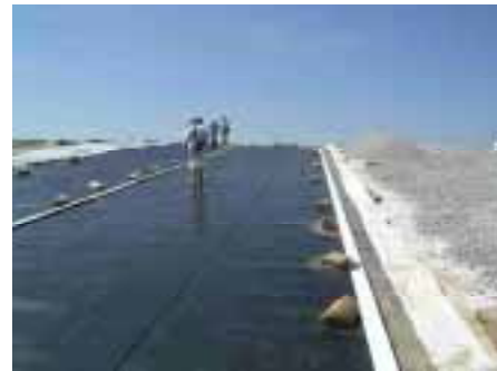
Fachgerecht verlegte Kunststoffdichtungsbahn.
