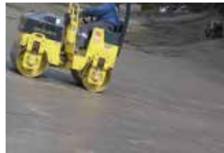
Einbau einer Tondichtung.
