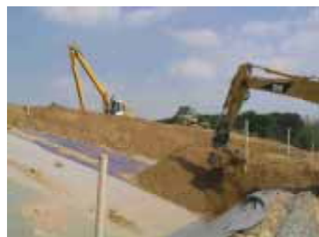
Lockerer Einbau von Rekultivierungsschichten.
