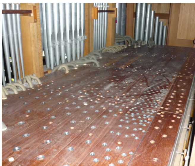
Die Hauptwerk-Windlade nach dem Ausbau der Pfeifen
