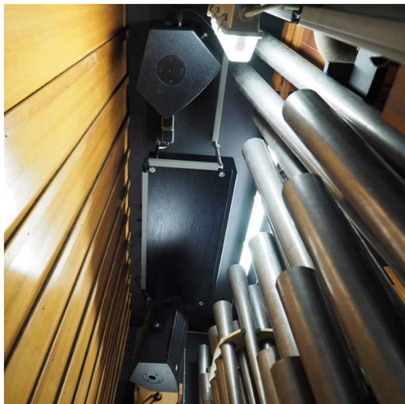
Subwoofer und Satelliten im Schwellwerk
