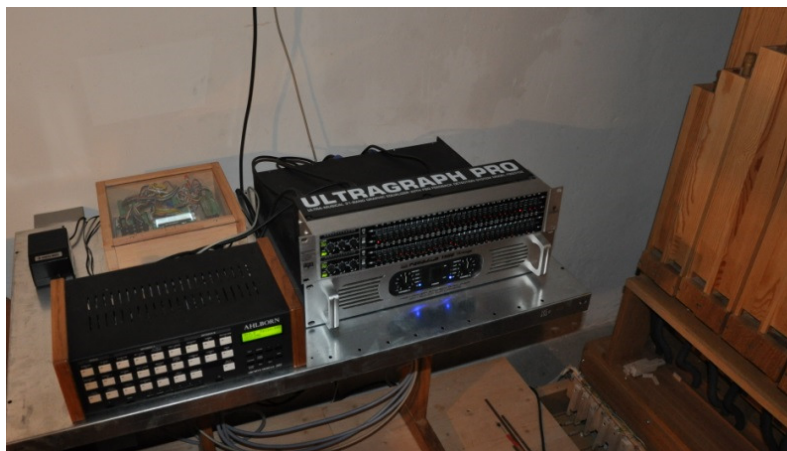
Die Installation im Turmzimmer hinter der Pfeifenorgel
