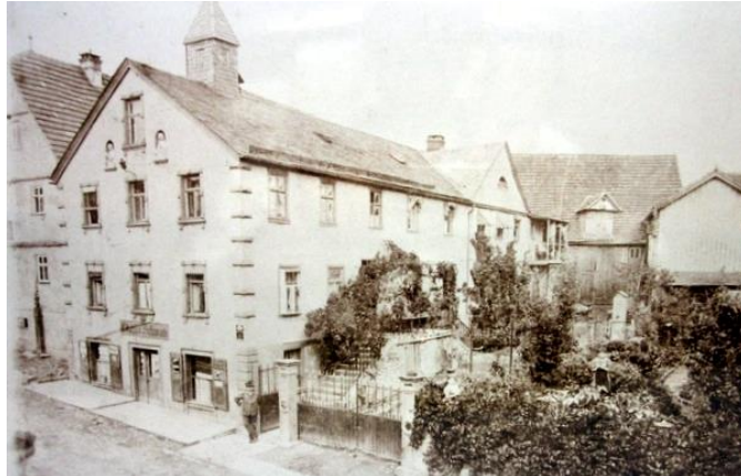
Das Kaufhaus Schwab in der Burghäuser Straße in Altbessingen
