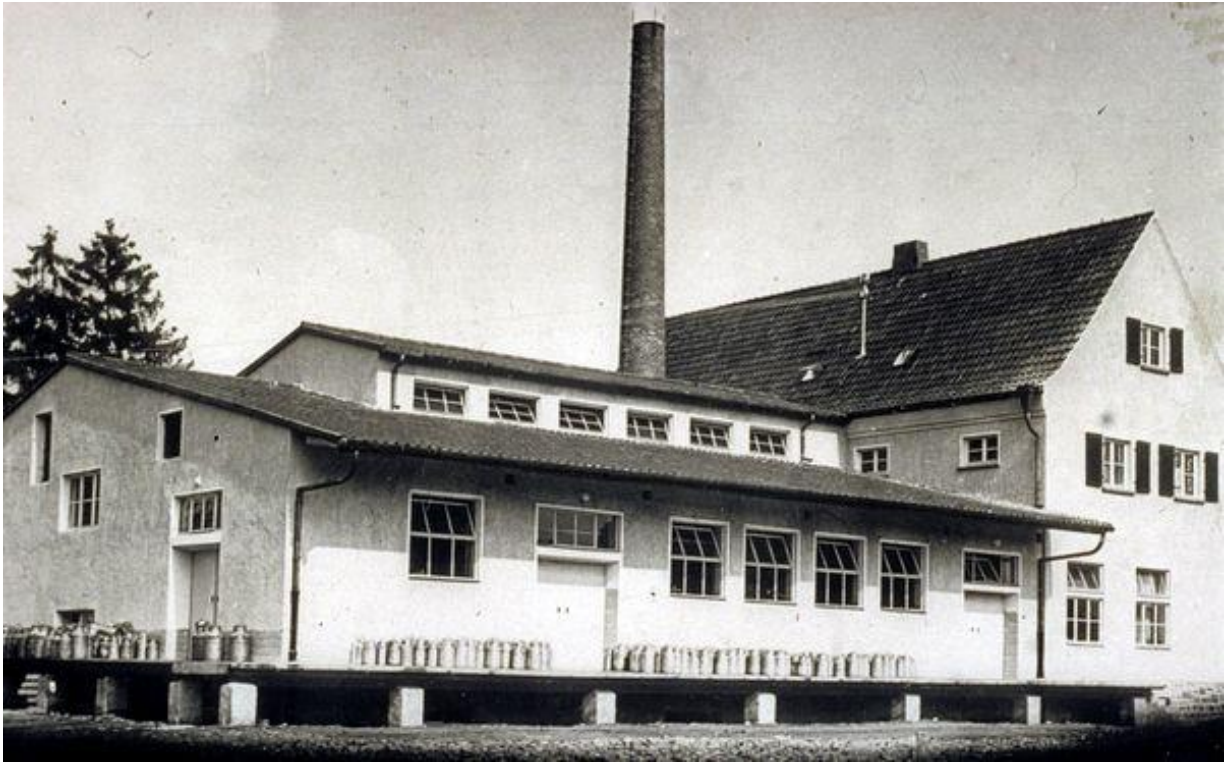
Das Gebäude der Molkerei Schipper in der Karlstadter Straße, heute Hofriedplatz. Es ist erstaunlich, dass Ludwig Schipper in seiner Autobiografie dieses Thema mit keinem Wort erwähnt.
