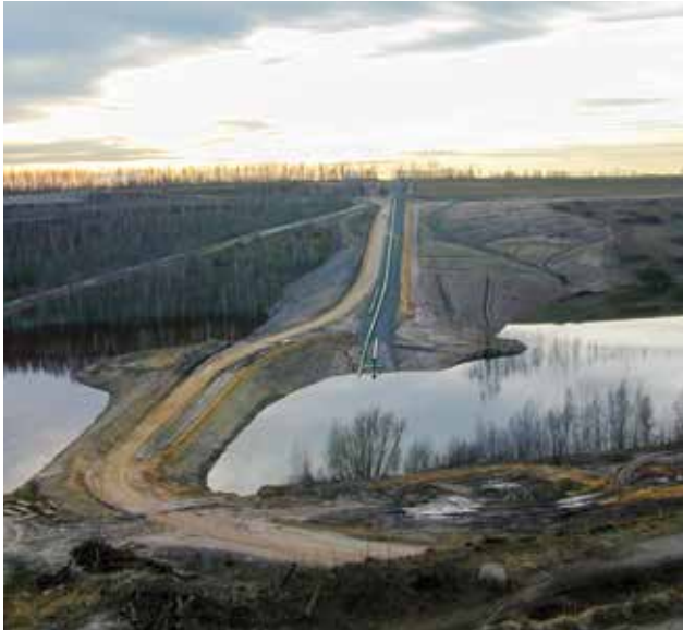
Errichtung der Einleitstelle für die Fremdfutung des Restlochs Störmthal, 2002
