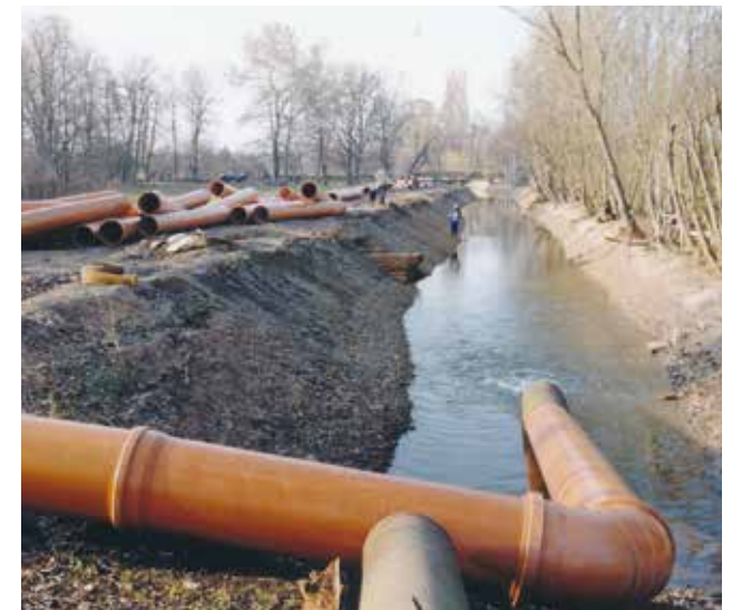
Nachholende Gewässerunterhaltung und Entschlammung der Kleinen Pleiße zur Gewährleistung der Überschusswasserableitung aus den Espenhainer Bergbaufolgeseen, 2001
