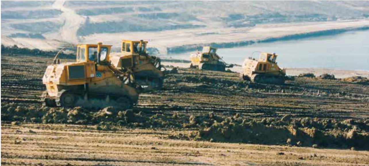
Böschungabflachung mit Schürfkübelraupen im Restloch Markkleeberg-Auenhain, 1997
