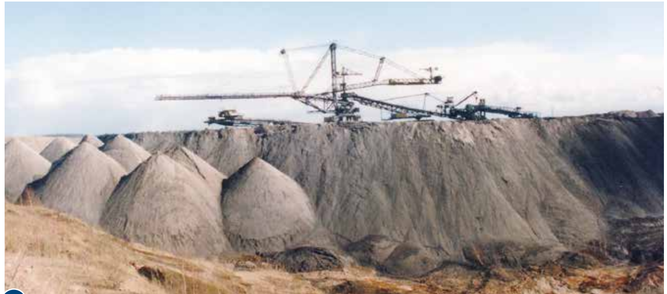
4 Fertigstellung des Pionierdamms zur Herstellung der Landbrücke bei Güldengossa, 1997
