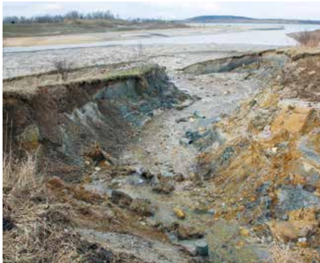
Hochwassereinbruch über das Einzugsgebiet des Göselbaches in die Grunaer Bucht des Störnthaler Sees, 2011
