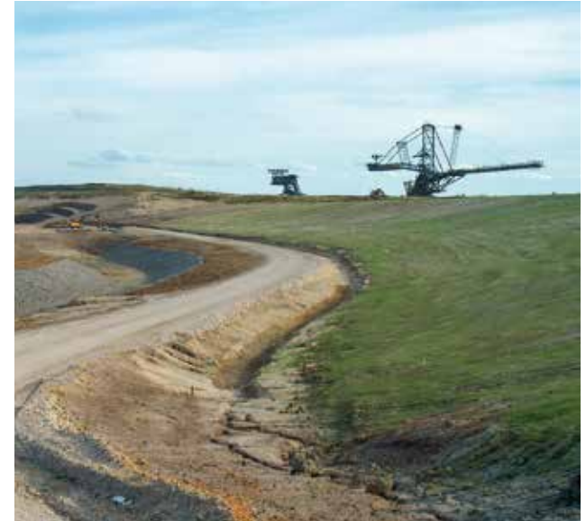
Herstellung des Verbindungskanals vom Störmthaler zum Markkleeberger See zwischen 2003 und 2012, 2004
