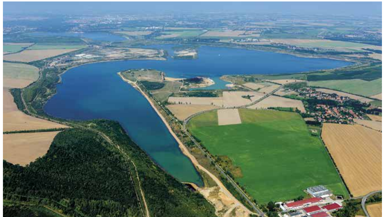
Gewässersystem Markkleeberger und Störmthaler See, 2014
