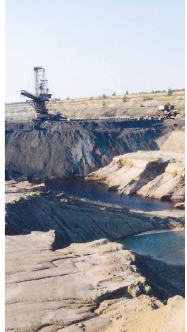
Teilschließung des durch die AFB technologisch bedingt hinterlassenen Randschlauchs am Sicherheitspfeiler Nord zwischen den Ortschaften Güldengossa und Störmthal und Herstellung einer Wasserwechselzone im künftigen Störmthaler See, 2000
