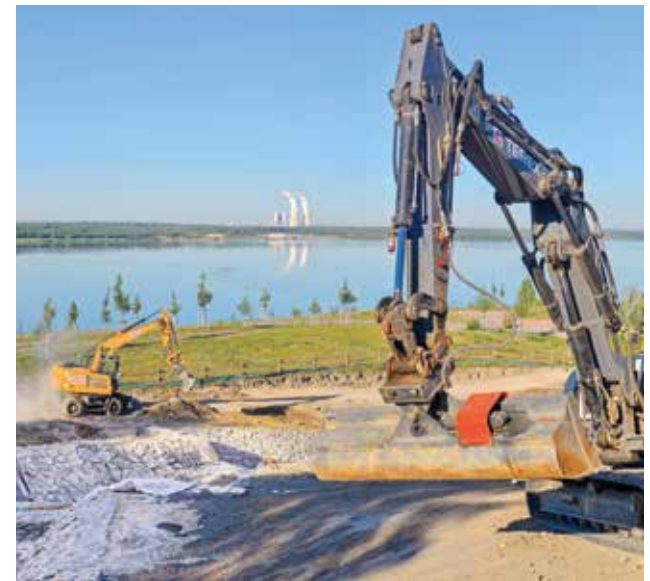
Einbindung des Schlumberbachs in den Störmthaler See, 2018
