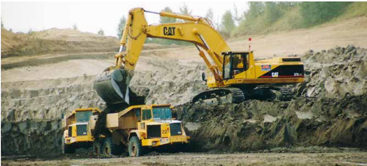
Massenbereitstellung und Sanierung im Bereich der Innenkippe im Restloch Markkleeberg-Auenhain, 1998
