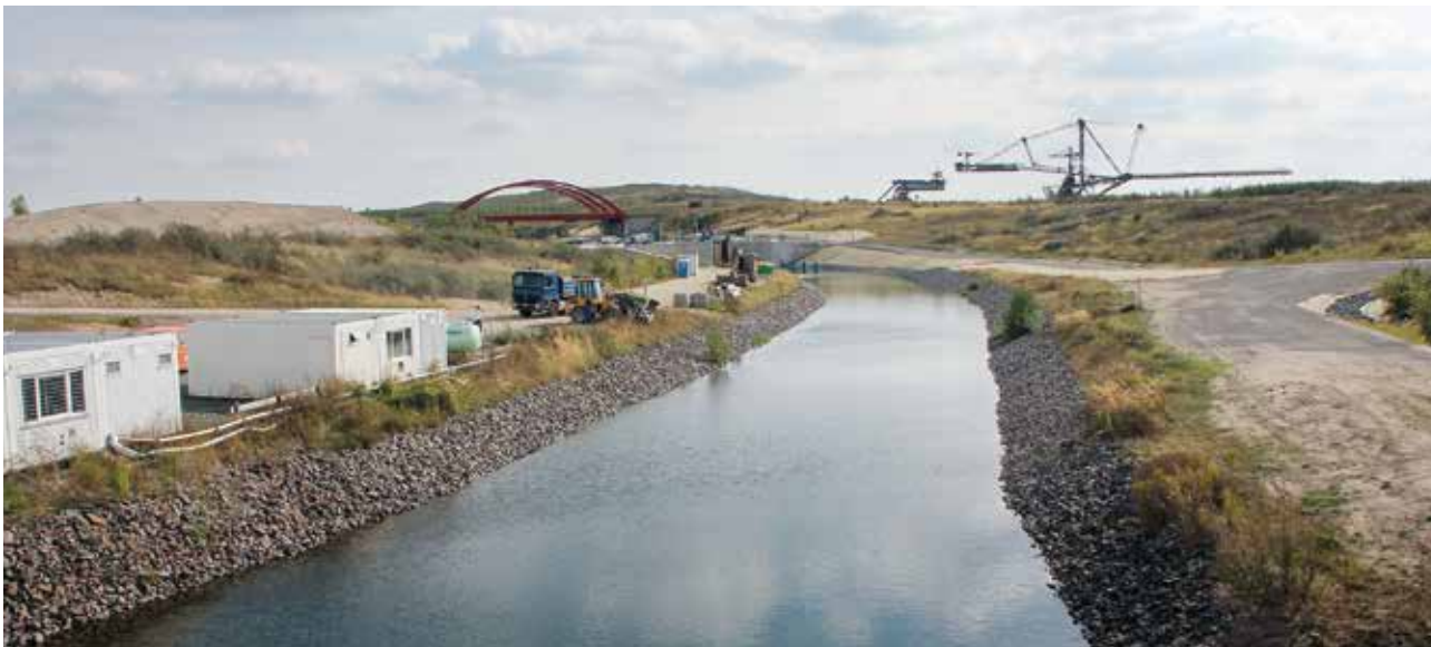
Schleusenbaustelle im Gewässerverbund zwischen Markkleeberger und Störmthaler See, Sommer 2012
