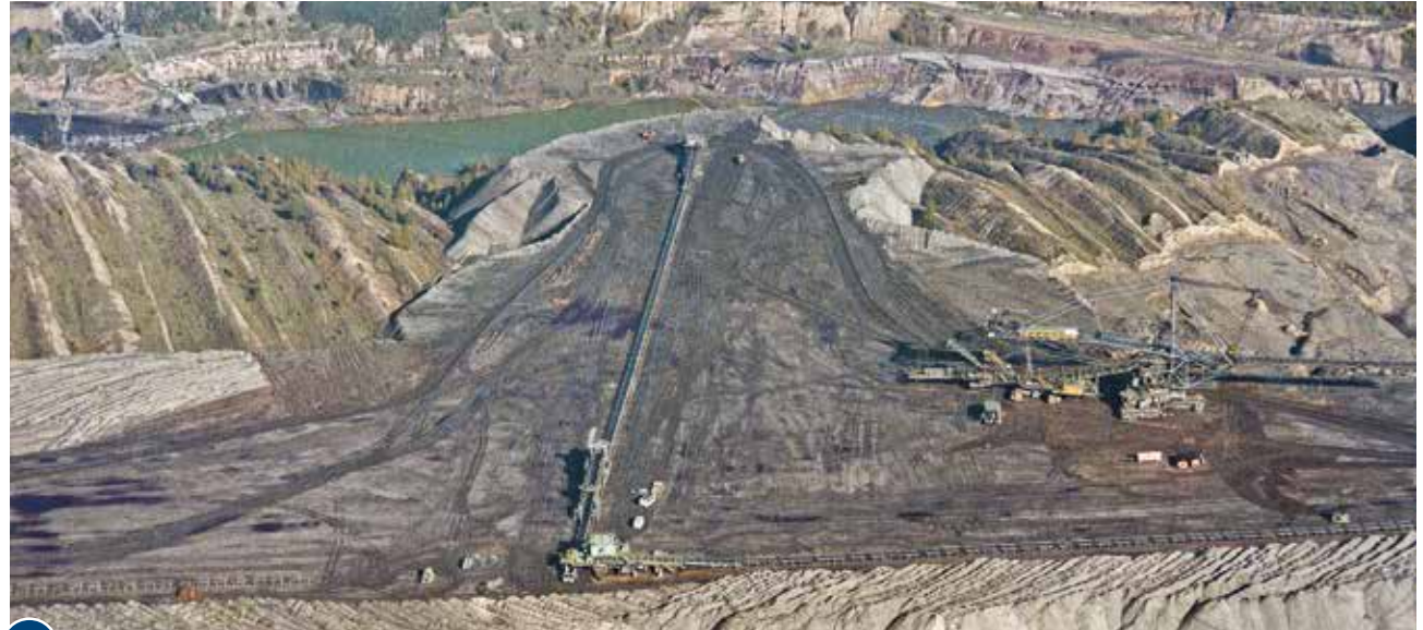
3 Schüttung der Restlochabgrenzung (Landbrücke bei Güldengossa) zwischen den Restlöchern Markkleeberg und Störmthal 1996–1999
