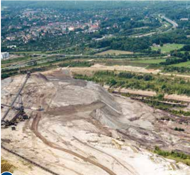
1 Anstützung Sicherungspfeiler West im Restloch Markkleeberg zur Herstellung eines Biotobverbunds östl. d. B2/95
