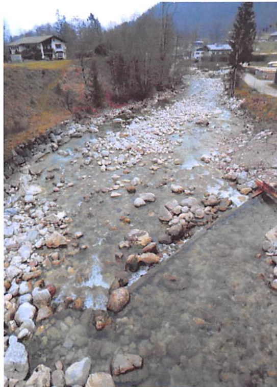
Abbildung 4: Blick von der Brücke auf die Mindestwasserstrecke der Königssee Achen.
