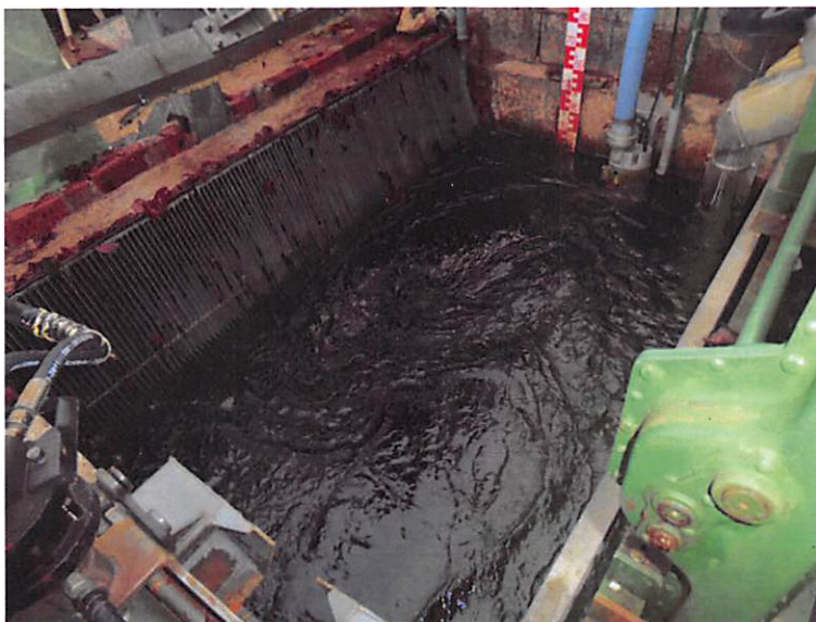
Abbildung 2: Einlaufrechen - Fischschutzrechen mit 15 mm lichter Weite und vertikaler Stabanordnung.
