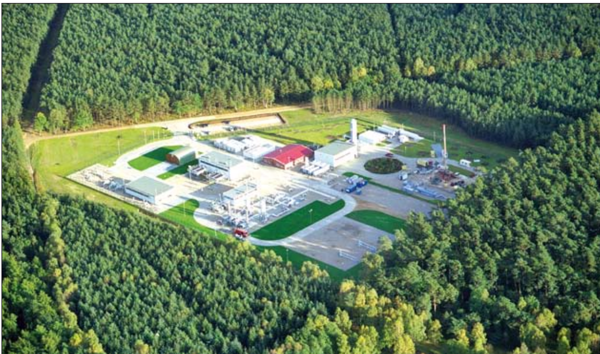
Abb. 16: Betriebsgelände des Untergrundspeichers Kraak im Landkreis Ludwigslust - Erdgasspeicherung in gesolten Kavernen (Quelle: Bergamt M-V)
