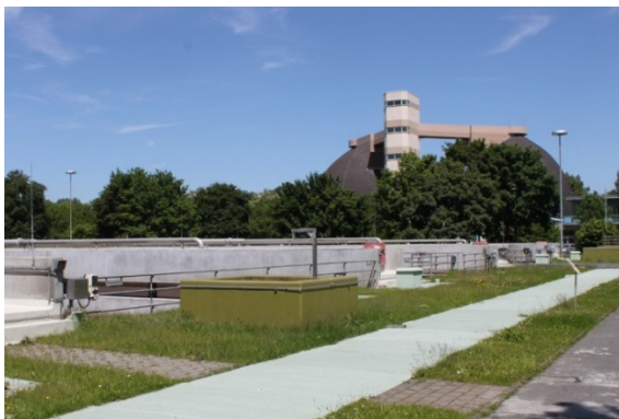
Zentralkläranlage in der Industriestraße
