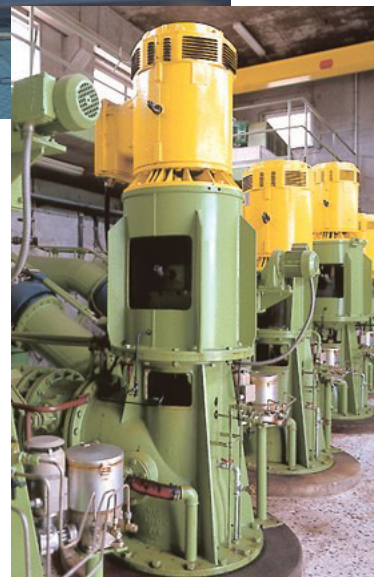
Belebungsbecken Zulaufpumpwerk
