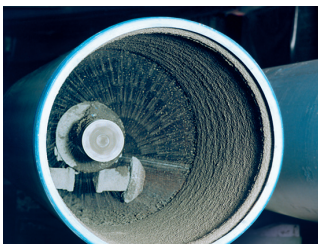
Auskleidung durch das Anspritzverfahren
