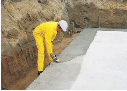
Bild 9-10: Abdichtung bei Sickerwasser
