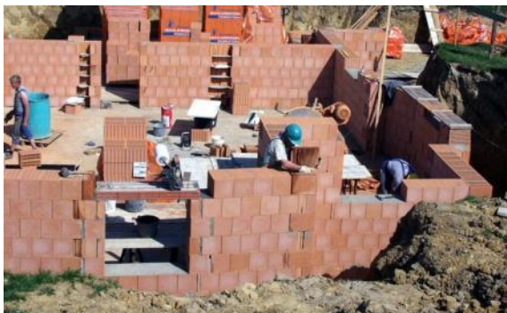
Bild 9-9: Blick auf den Bauzustand der Kellerwand ohne Verfüllung
