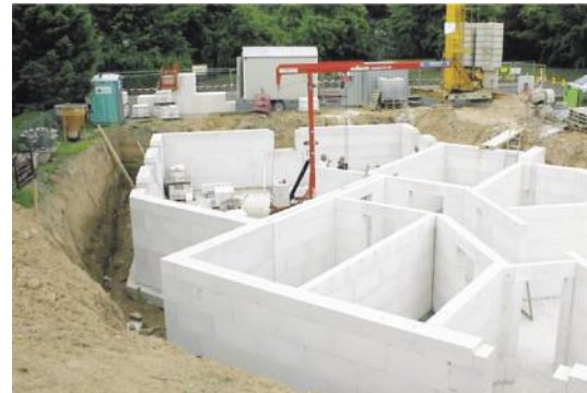
Bild 9-9: Blick auf den Bauzustand der Kellerwand ohne Verfüllung
