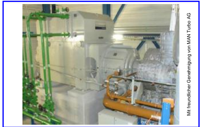
Dampfturbinsensatz mit E-PACK ® -Getriebe (Beispiel)
