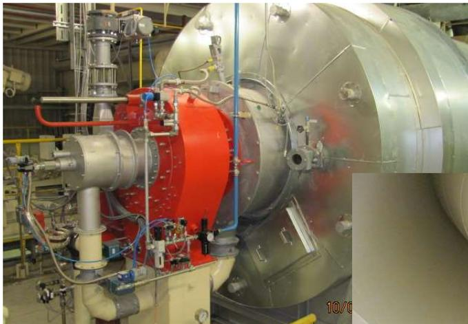
**Brennkammer und Mehrstoffbrenner**
