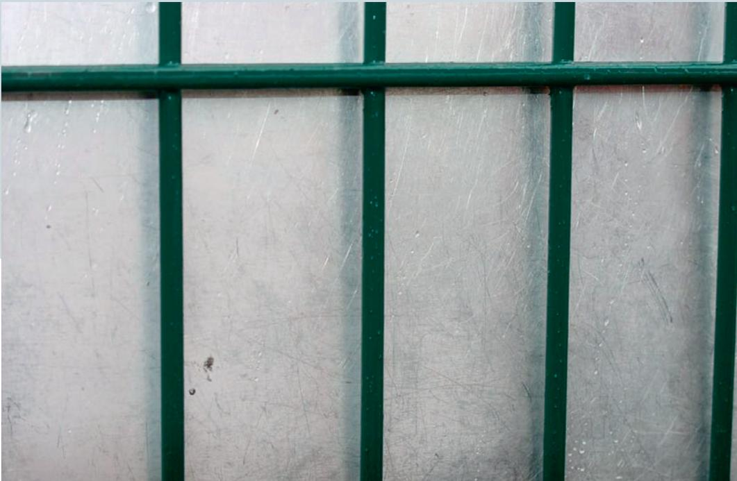
Die Unregelmässigkeiten auf der Duplex-Beschichtung des Zaunelementes sind verfahrensbedingt und aus dem vorgeschriebenen Betrachtungsabstand von fünf Metern nicht mehr zu erkennen.
