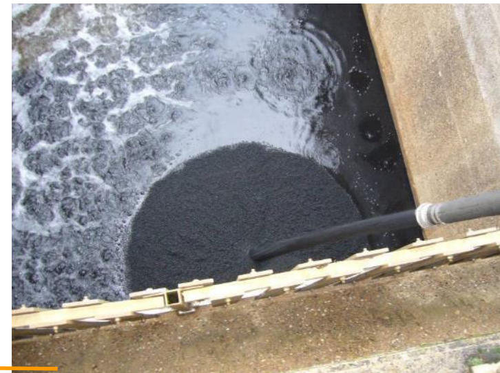
Treibwasserentnahme (Storz C)
