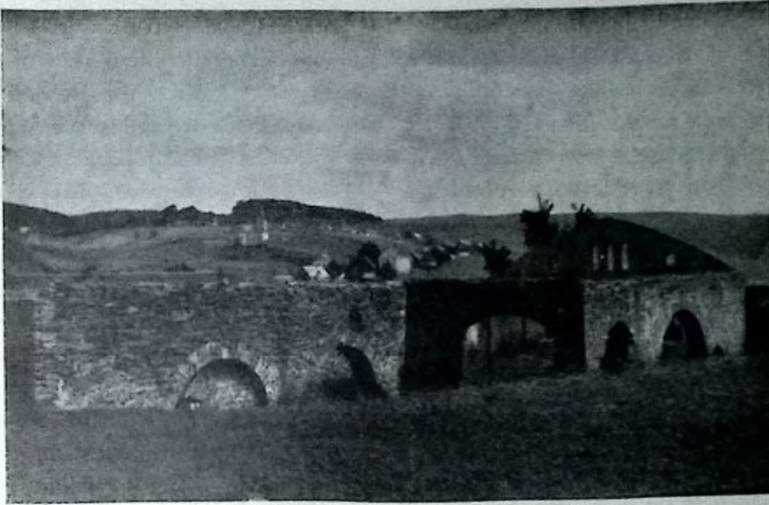
Puddelwerk in XaUich.
