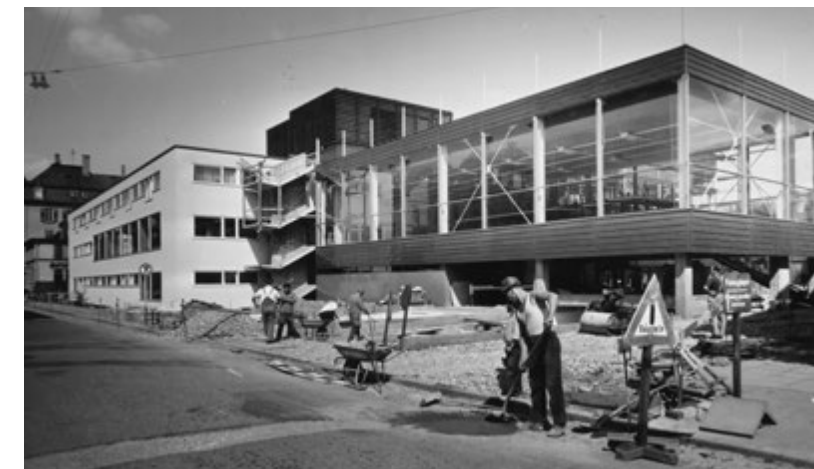
Die neue Mensa kurz vor ihrer Fertigstellung
