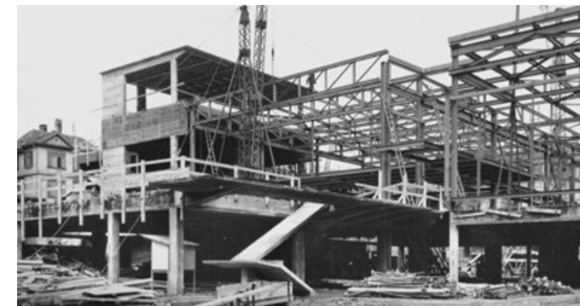
Die Bauarbeiten in einem frühen Stadium
