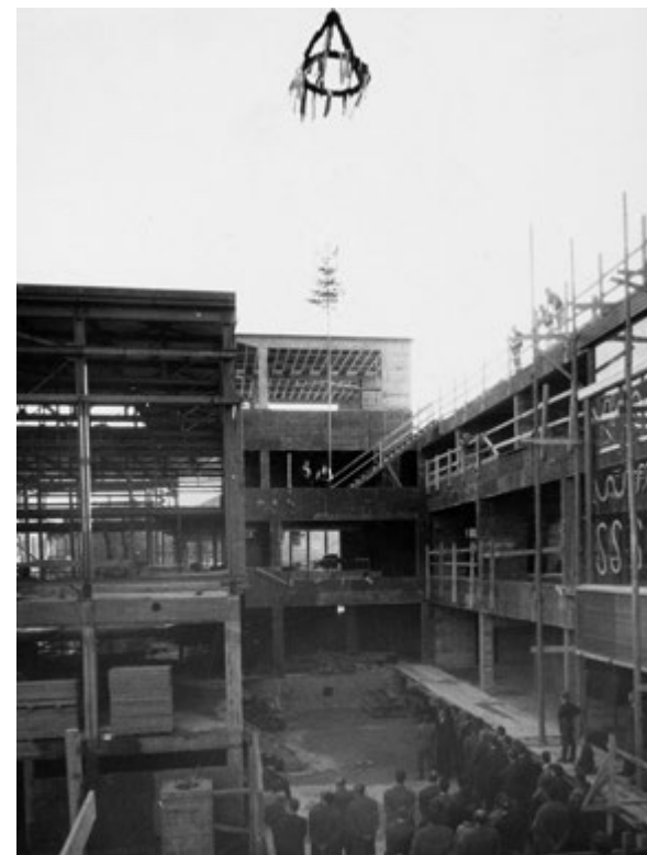
Richtfest der Mensa Wilhelmstraße
