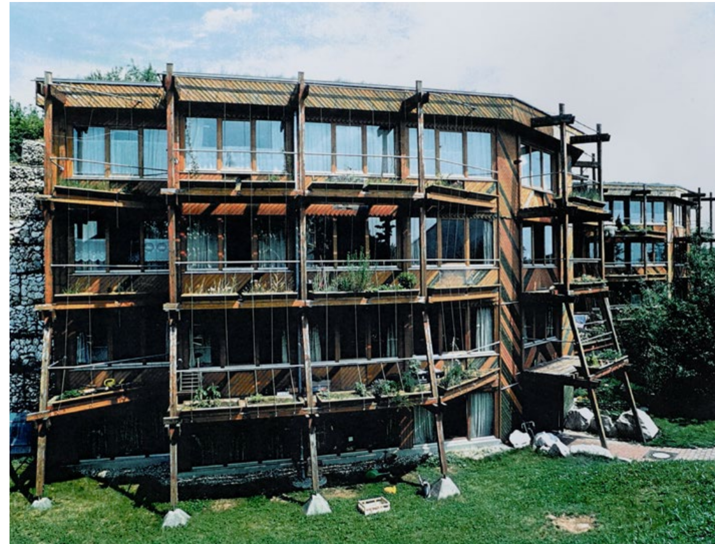
Blick auf eines der 6 Häuser, die in Erdhügel »hineingebaut« wurden
