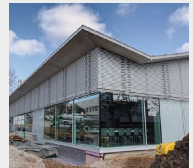
Anbau der Mensa Hohenheim
