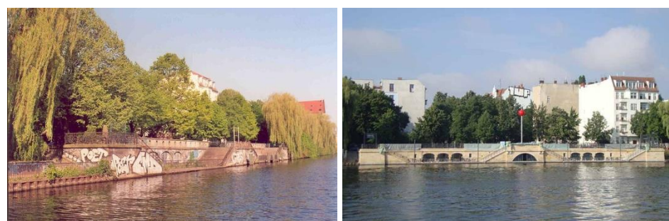
Abb. 15 (li.): Doppelkaianlage vor dem Umbau Quelle: Herwarth + Holz
