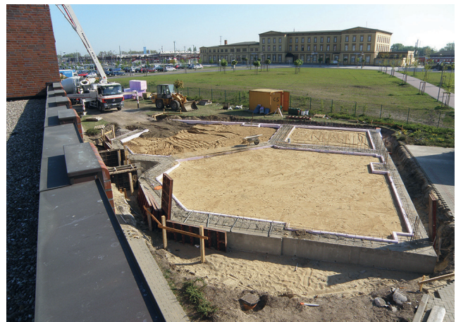
Bild 57: Baubeginn der neuen Seminar- und Praxisräume im April 2009
