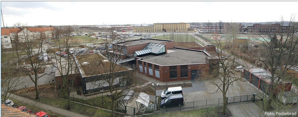
Bild 58: Blick auf das Ausbildungszentrum von oben im Jahr 2018
