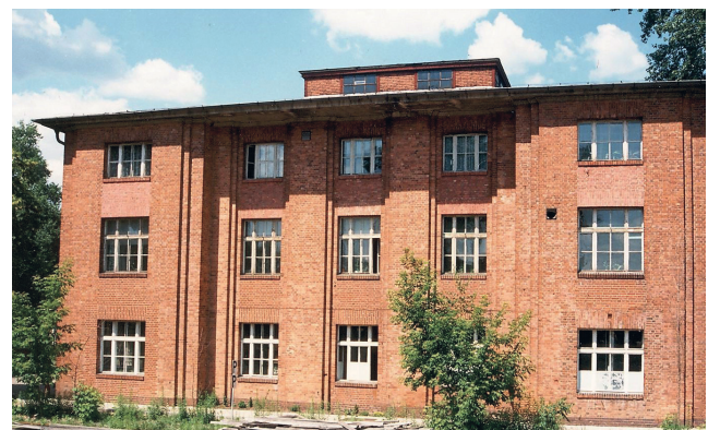
Bild 30: Mechanische Versuchsanstalt (MVA) auf dem Gelände des RAW Brandenburg-West (Kirchmöser)
