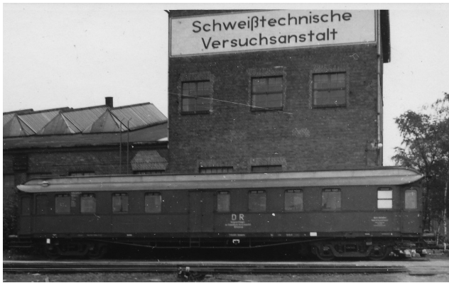
Bild 20: Röntgenprüfwagen der SVA Wittenberge nach 1950
