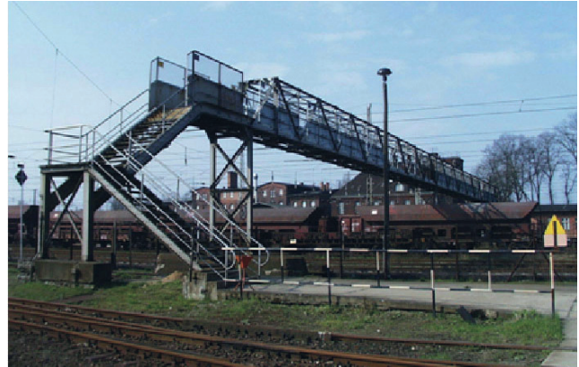
Bild 47: Die Fußgängerbrücke, der Verbindungsweg vom Schulgebäude zum Bahnhofsvorplatz, wurde 2002 abgerissen
