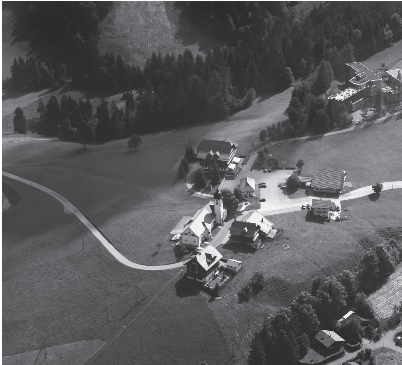
Flugbild Bruno Pellandini 2006 © Kantonale Denkmalpflege Luzern
